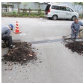
側溝清掃・補修
