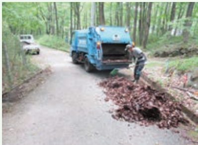
側溝清掃作業中 (上の原高原別荘地)
