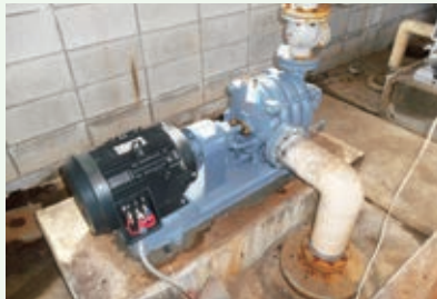
5期タービンポンプ交換工事 (景勝苑別荘地)
