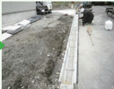
側溝補修工事作業中 桜台別荘地
