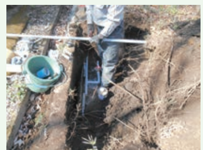
漏水修理工事 グレートハイランド別荘地
