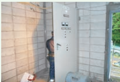
3期制御盤交換工事 (景勝苑別荘地)
