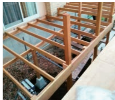
根太入れ工事作業中
