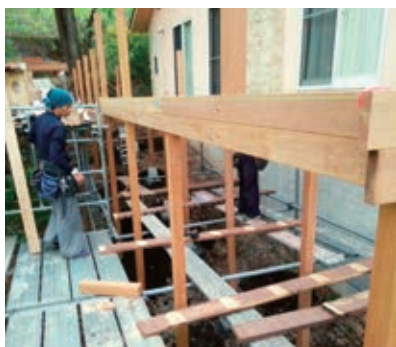
柱立て工事作業中
