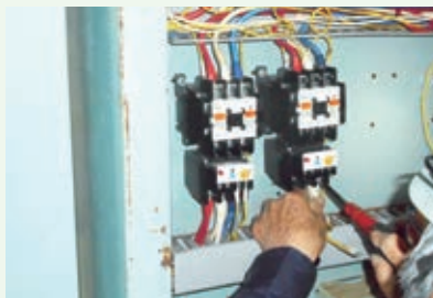
5期マグネットスイッチ交換工事 (景勝苑別荘地)
