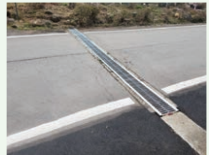
横断溝補修工事完了 グレートハイランド別荘地
