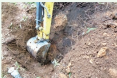
掘削工事作業中
