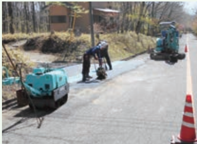
横断溝設置工事作業中 (バケーションランド別荘地)
