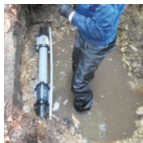
給水管漏水修理・維持管理
