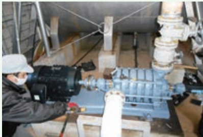
3期タービンポンプ交換工事 (景勝苑別荘地)
