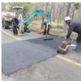
道路補修・清掃
