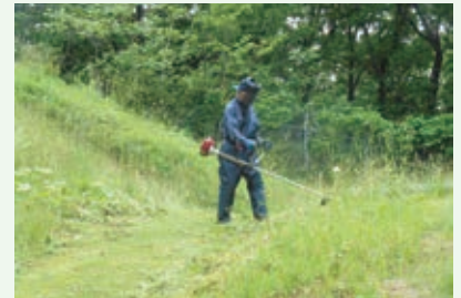
水道施設内草刈作業 (バケーションランド別荘地)
