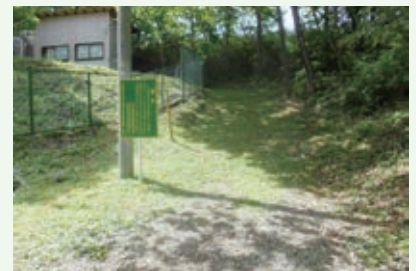
水道施設内草刈作業実施 (グレートハイランド別荘地)
