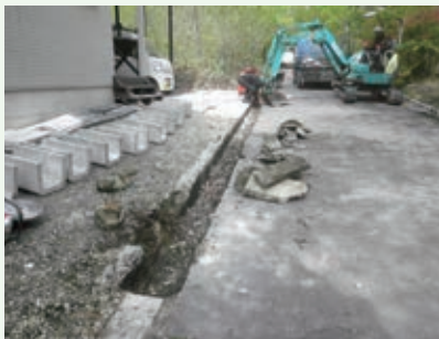
掘削工事作業中 桜台別荘地
