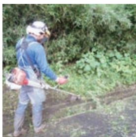
道路路肩の草刈り
