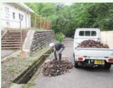
側溝清掃作業中 桜台別荘地
