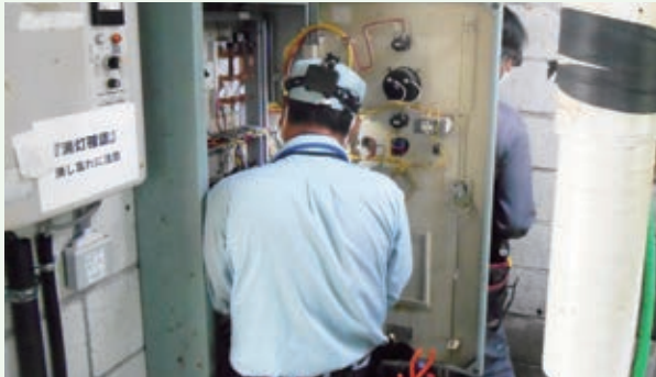
施設制御盤交換工事 (那珂川8期別荘地)
