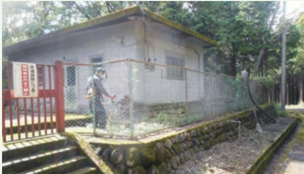
水道施設内環境整備作業中 (八方高原別荘地)
