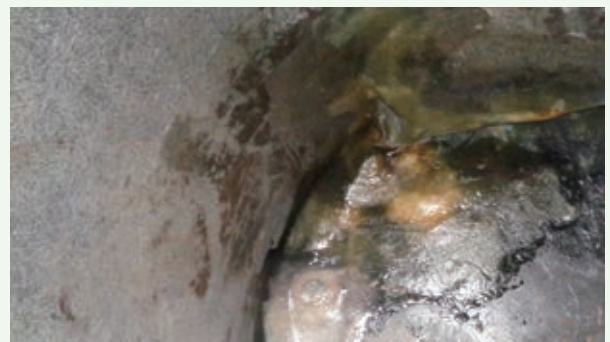
浄化槽内亀裂修繕工事 完了
