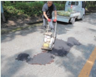
道路補修工事 (バケーションランド別荘地)
