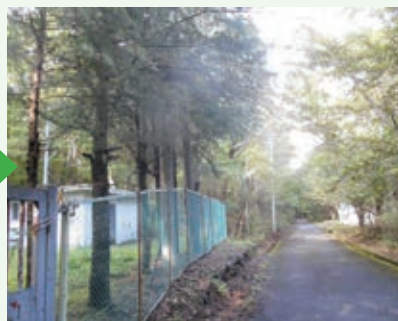
水道施設内枝打ち作業 完了 (上の原高原別荘地)
