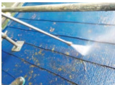
屋根の高圧洗浄作業中
