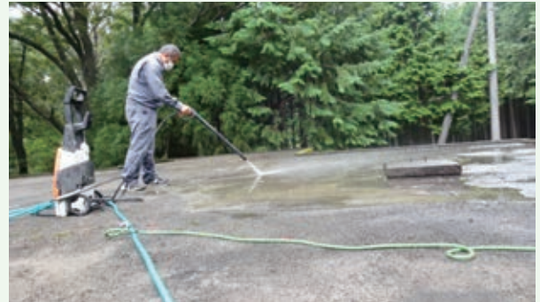
水道施設屋根の高圧洗浄作業中 (八方高原別荘地)
