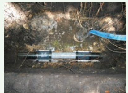
送水管漏水修理工事 (景勝苑別荘地)
