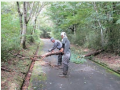
倒木処理 作業中 (桜台別荘地)
