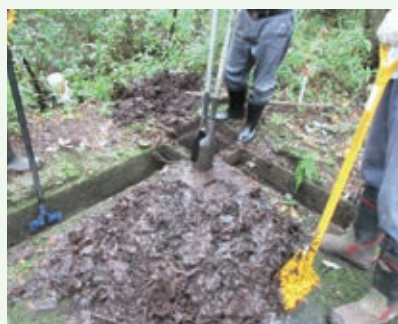
浸透樹清掃 作業中 (バケーションランド別荘地)
