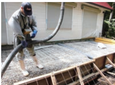
コンクリートテラス 打設作業中
