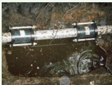
配水管漏水修理工事 (レークサイド別荘地)
