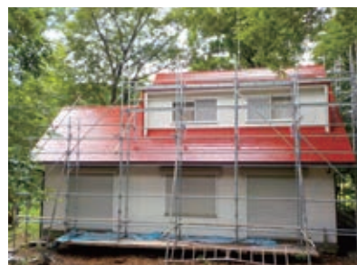
屋根の塗装工事作業中
