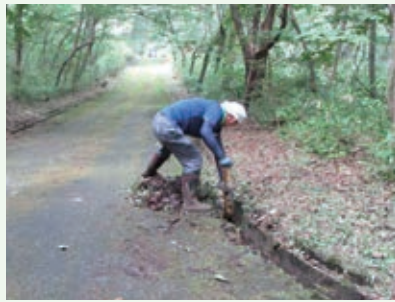
側溝清掃 作業中 (吉野台別荘地)
