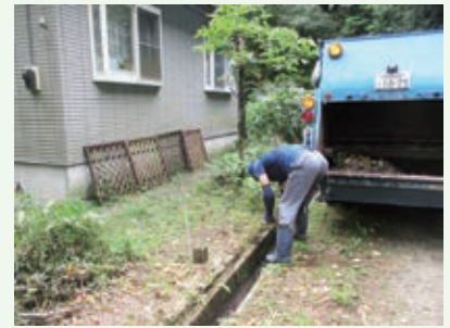
側溝清掃 作業中 (景勝苑別荘地)
