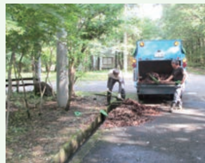
側溝清掃 作業中 (上の原高原別荘地)
