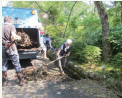
側溝清掃 作業中 (バケーションランド別荘地)
