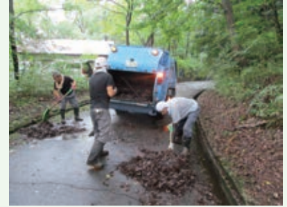
側溝清掃 作業中 (桜台別荘地)
