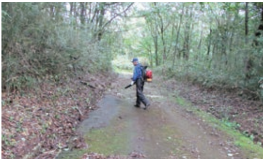
道路補修・清掃
