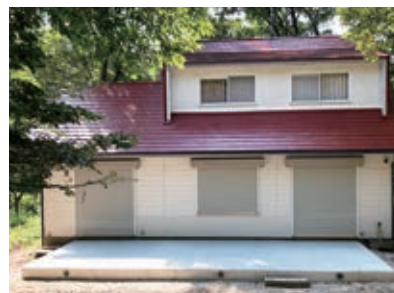
外観 工事完了
