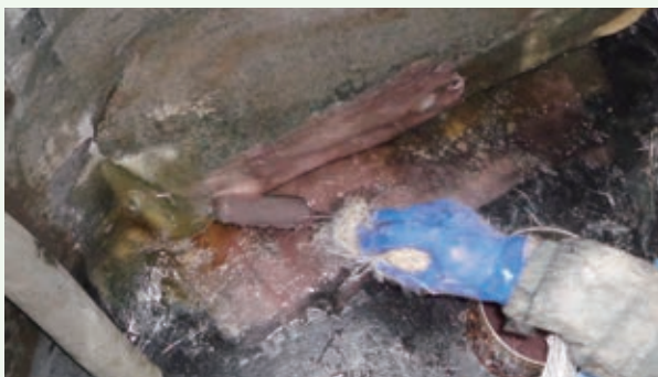
浄化槽内亀裂修繕工事 作業中
