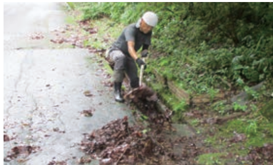
側溝清掃・補修
