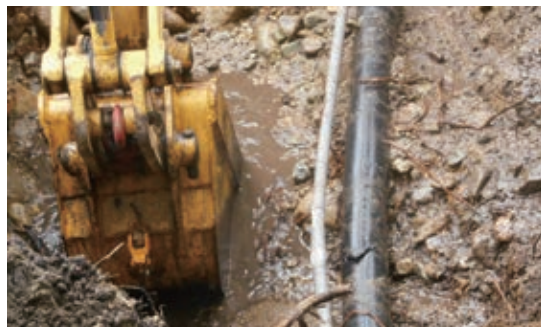
給水管漏水修理・維持管理
