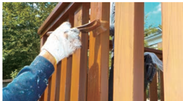
塗装工事 作業中
