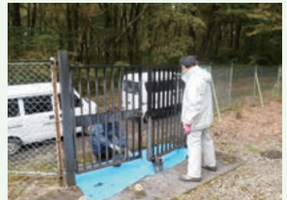
水道施設内環境整備 作業中 (吉野台別荘地)
