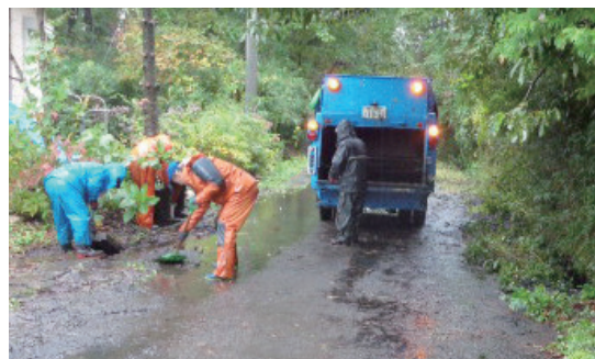
側溝清掃・補修
