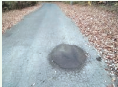
道路補修工事 完了 (那珂川別荘地)
