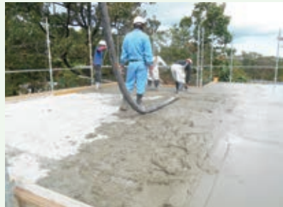
水道施設天井改修工事 作業中 (桜台別荘地)
