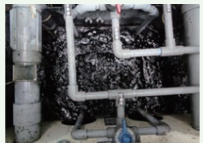
ブロワ交換工事完了後の内部 新しいブロワから送られた空気で 攪拌して汚水分解している状態
