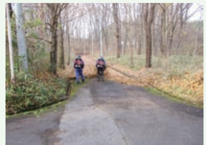
道路清掃 作業中 (レークサイド別荘地)
