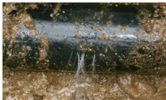
給水管漏水修理・維持管理
