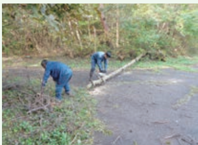
倒木処理 作業中 (湯の里村別荘地)
