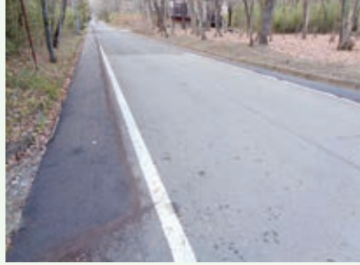
道路補修工事 完了 (グレートハイランド別荘地)
