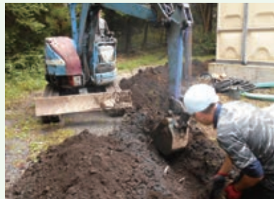
井戸配管敷設替工事 作業中 (那珂川八期別荘地)
