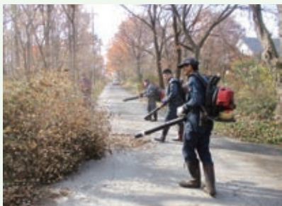
道路清掃 作業中 (那珂川別荘地)
