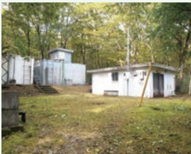
水道施設内草刈作業 実施 (上の原高原別荘地)
