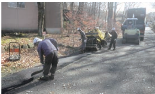
道路補修・清掃
