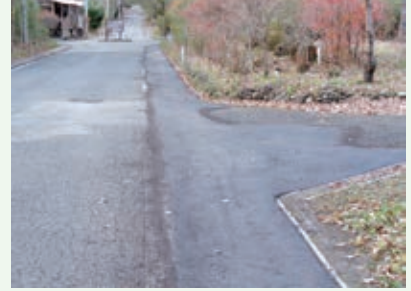
道路補修工事 完了 (グレートハイランド別荘地)
