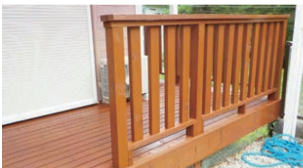
塗装工事 完了
