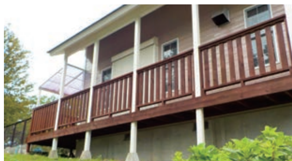
塗装工事 完了
