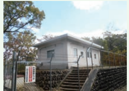
水道施設改修工事 完了 (桜台別荘地)
