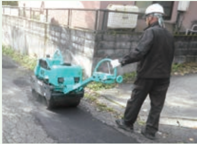
道路補修工事 作業中 (第一新那須高原別荘地)
