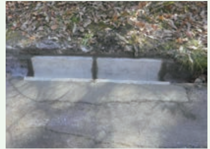
側溝補修工事 完了 (桜台別荘地)
