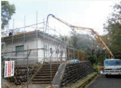
水道施設改修工事 作業中 (桜台別荘地)
