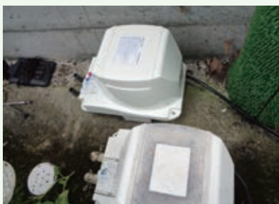
手前が古く壊れたブロワで、奥が今回取り付けした新しいブロワ
