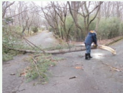
2月16日撮影 強風による倒木処理 作業中 (バケーションランド別荘地)
