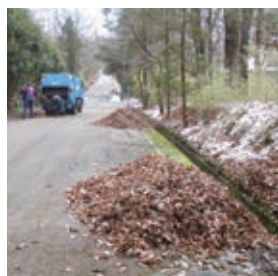
側溝清掃・補修
