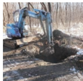
給水管漏水修理・維持管理
