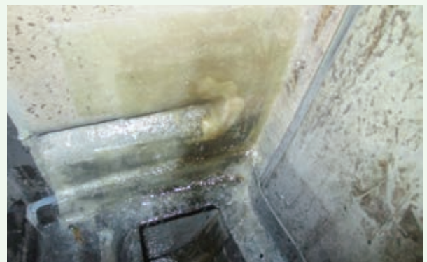
浄化槽内の修繕工事 完了
