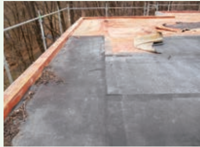
天井原状回復工事 作業中 (レークサイド別荘地)
