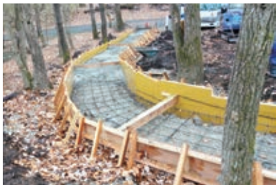
生コンクリート 注入中
