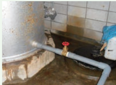
加圧タンク排泥バルブ交換工事 実施 (景勝苑別荘地)
