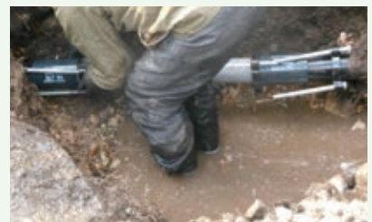
送水管漏水修理工事 作業中 (景勝苑別荘地)
