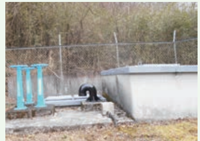
水道施設内塗装工事実施 (那珂川別荘地)
