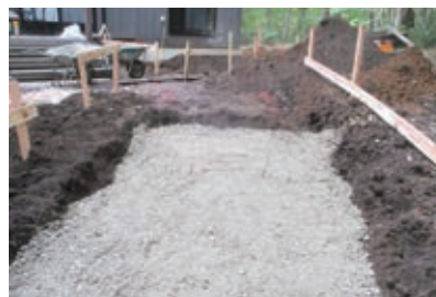
砕石敷き込み 作業中
