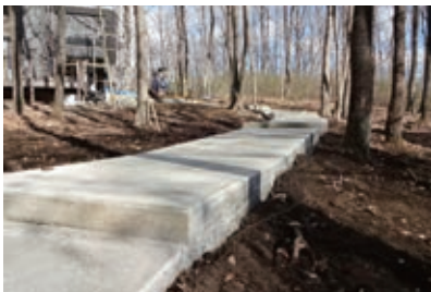
スロープ 完成
