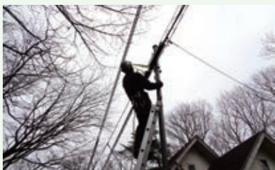
街路灯交換 作業中 (山吹台9期別荘地)
