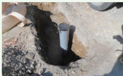
止水バルブ設置工事 作業中 (グレートハイランド別荘地)
