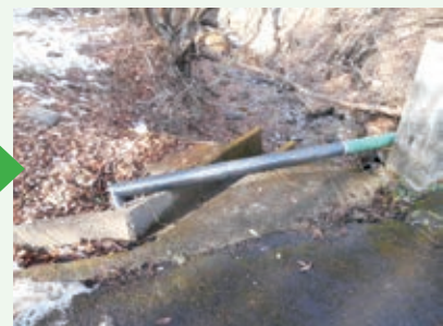
漏湯修理工事 完了 (上の原高原別荘地)
