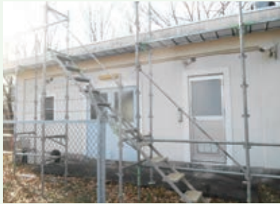
水道施設 天井原状回復工事前 (レークサイド別荘地)
