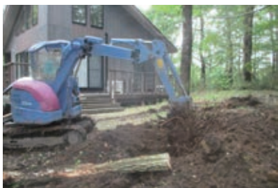
掘削工事 作業中
