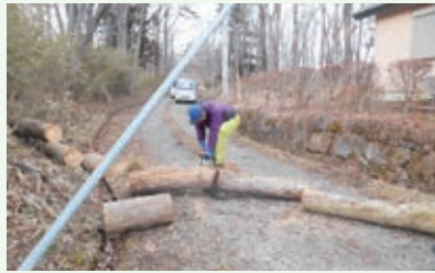
2月16日撮影 街路灯を巻き込んだ倒木処理作業中 (第二緑泉別荘地)
