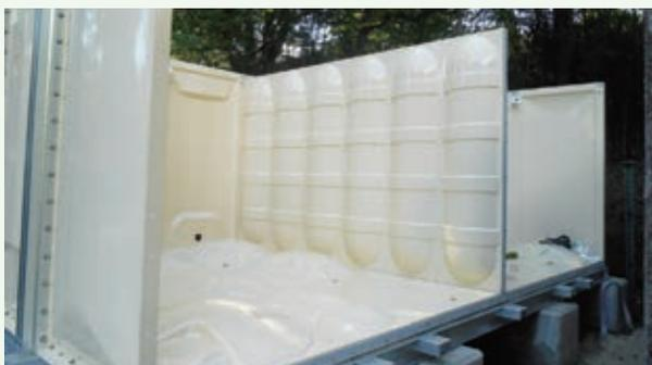
貯水槽設置 FRP槽組立工事 作業中
