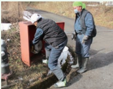
消火ホース格納庫補修工事 作業中 (レークサイド別荘地)
