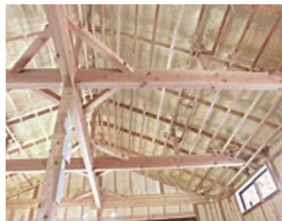
R天井下地工事
