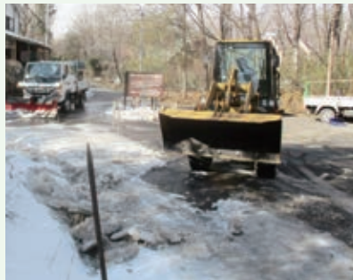
除氷作業 作業中 (グレートハイランド別荘地)
