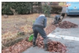
側溝清掃・補修
