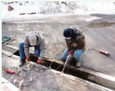
横断溝補修工事 作業中 (グレートハイランド別荘地)
