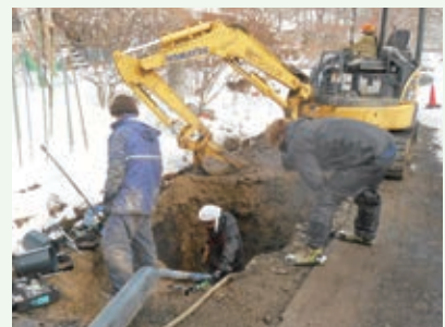
送水管漏水修理工事 作業中 (バケーションランド別荘地)
