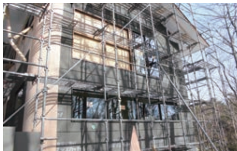
モルタル下地ボード取付工事
