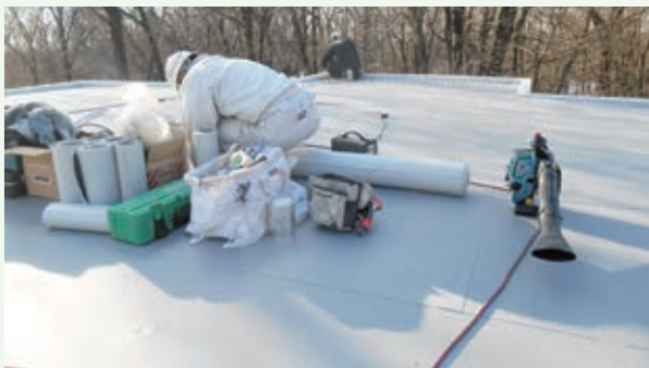
水道施設屋上防水改修工事 作業中 (レークサイド別荘地)
