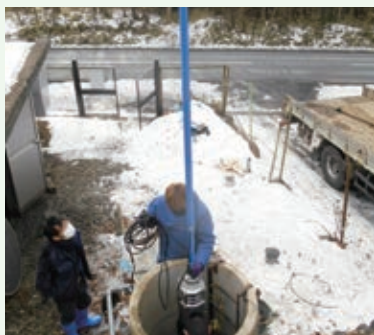
浸透槽水中ポンプ交換工事 作業中 (那珂川8期別荘地)
