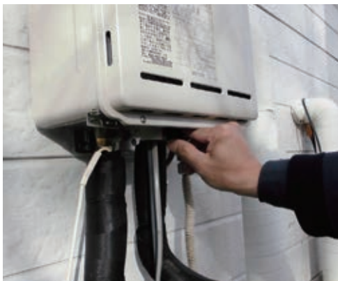
給湯器の水出確認作業中
