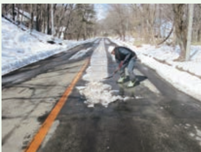
除氷作業 作業中 (バケーションランド別荘地)
