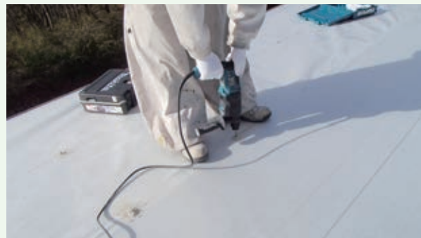
水道施設屋上防水改修工事 作業中 (桜台別荘地)
