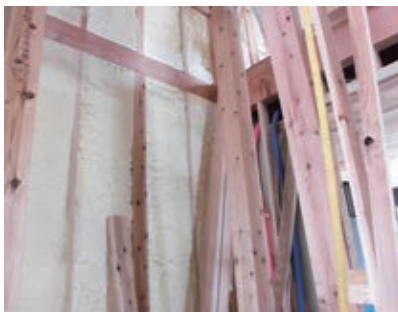
吹き付け断熱工事
