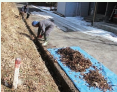
側溝清掃 作業中 (那珂川8期別荘地)
