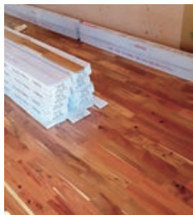
無垢材フローアー工事
