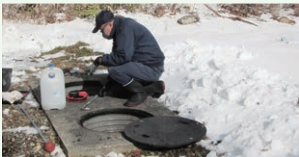
浄化槽定期点検 作業中
