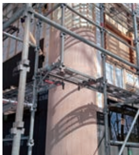
外壁R耐力壁工事
