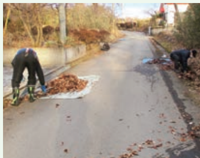
側溝清掃 作業中 (那珂川別荘地)
