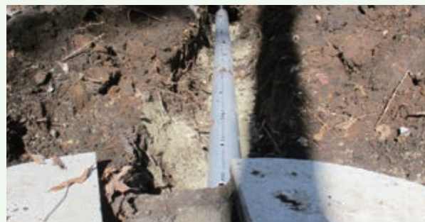
浸透管新規設置工事 作業中
