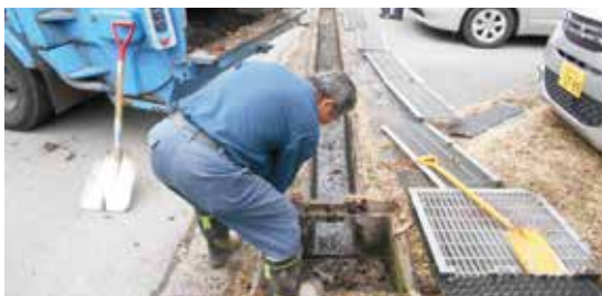
側溝清掃・補修
