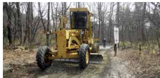
道路補修・清掃
