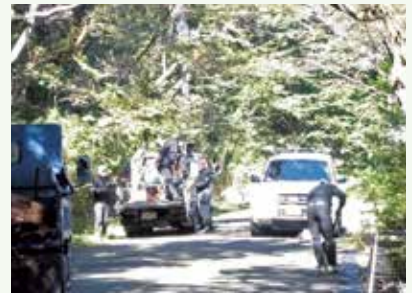
道路補修工事作業中 (桜台別荘地)
