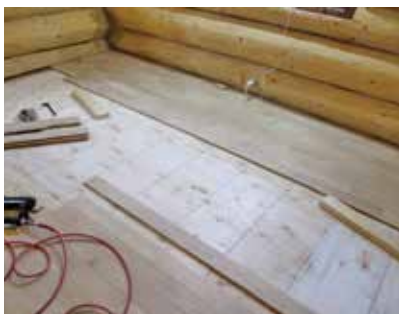
床無垢材敷き工事 作業中
