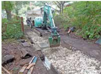
浸透枮設置工事作業中 (第1新那須高原別荘地)
