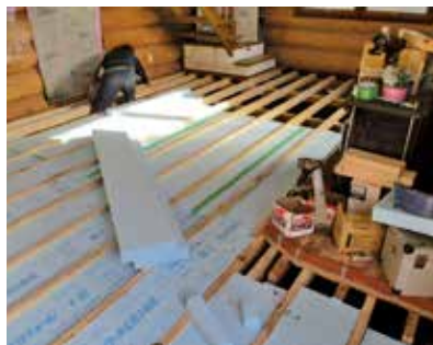
床断熱材工事 作業中
