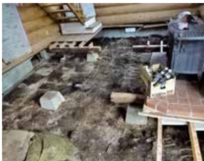
床解体工事 作業中
