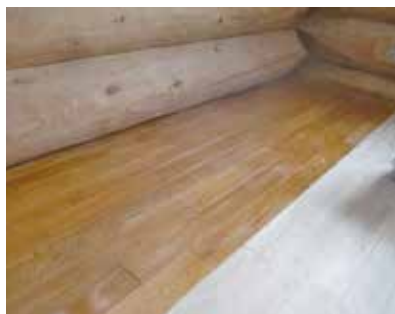
床塗装工事 作業中
