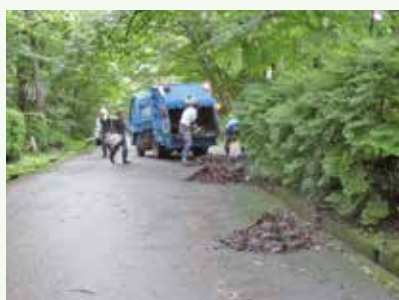
側溝清掃作業中 (上の原高原別荘地)
