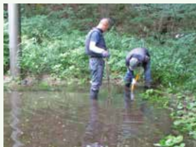
側溝溢れ対応中 (バケーションランド別荘地)
