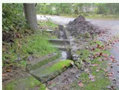
側溝清掃作業中 (上の原高原別荘地)
