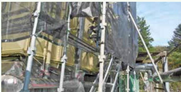
貯水槽塗装工事 作業中 (那珂川別荘地)
