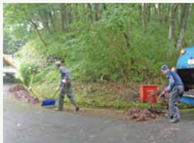
側溝清掃作業中 (長南寺別荘地)
