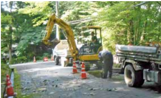
給水管漏水修理・維持管理
