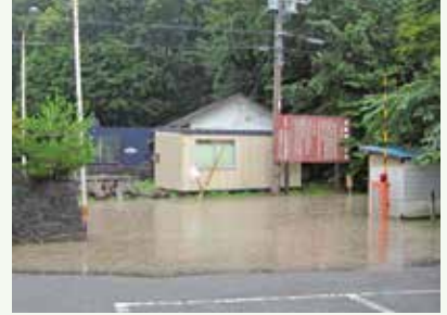
景勝苑別荘地入口付近の冠水状況
