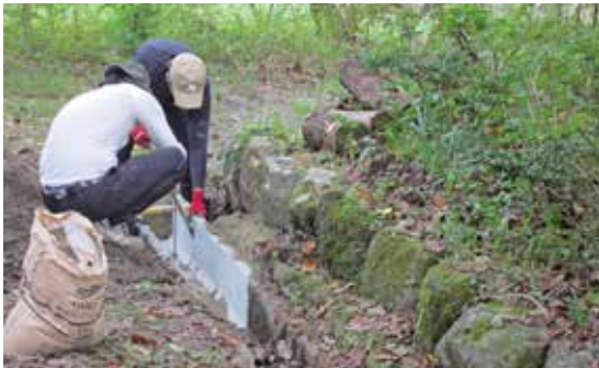
側溝清掃・補修
