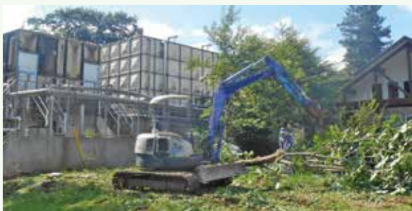
貯水槽隣接樹木伐採工事実施 (那珂川別荘地)
