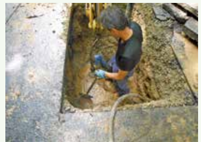
漏水修理工事作業中 (那珂川別荘地)
