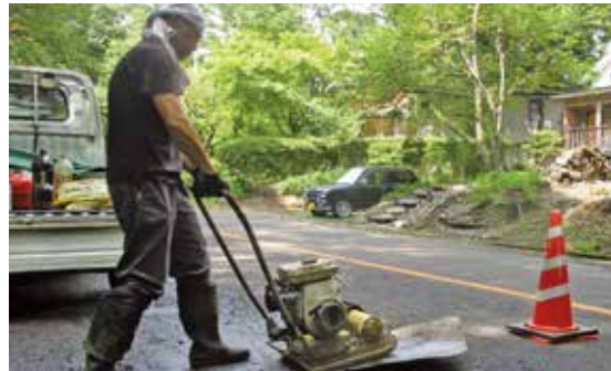
道路補修・清掃
