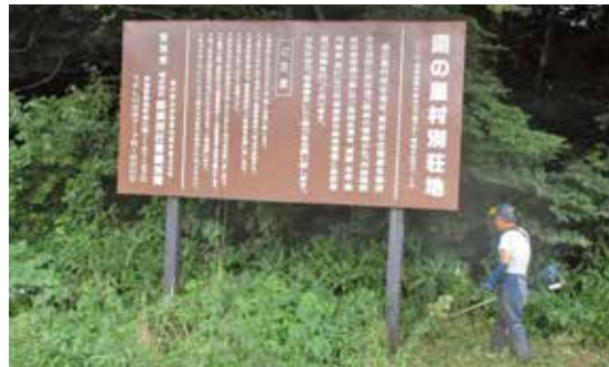
道路路肩の草刈り
