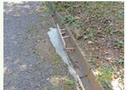
側溝補修工事作業中 (那珂川8期別荘地)
