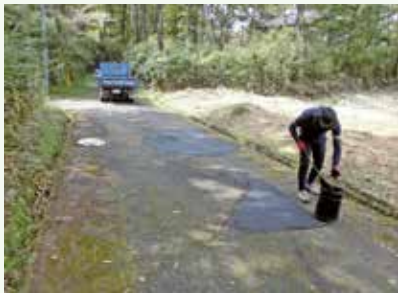
道路補修工事作業中 (レークサイド別荘地)
