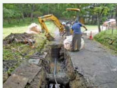
漏水修理工事作業中 (バケーションランド別荘地)
