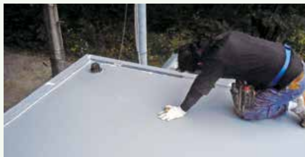
水道施設天井補修工事 作業中 (景勝苑別荘地)
