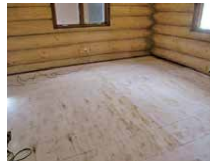
コンパネ敷き工事 作業中
