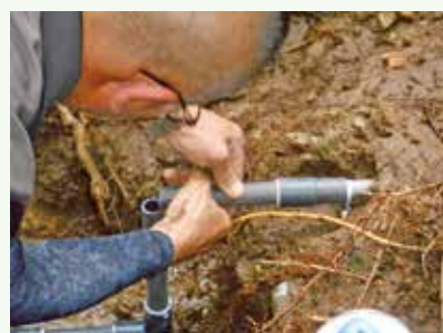
温泉管漏水修理工事作業中 (上の原高原別荘地)
