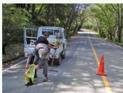
道路補修工事作業中 (バケーションランド別荘地)
