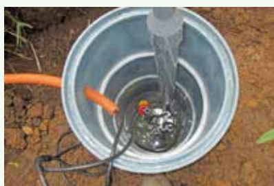
放流ポンプと逆止弁付きの浸透槽設置工事
