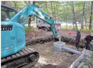
浸透枮設置工事作業中 (景勝苑別荘地)
