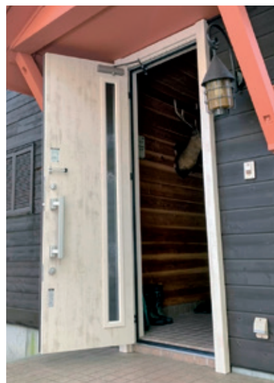
工事完了 玄関ドア裏側
