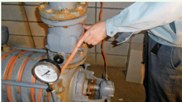
ヒーター線整備 作業中 (景勝苑別荘地)
