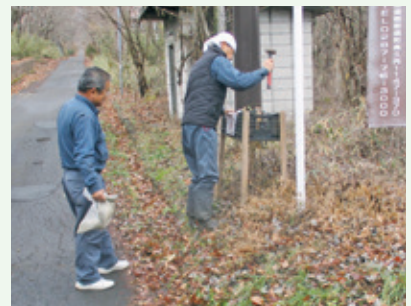
滑り止め用砂箱設置 (第1新那須高原別荘地)
