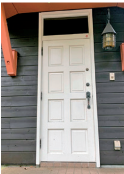
工事前 玄関ドア
