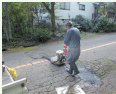
道路補修工事 作業中 (バケーションランド別荘地)
