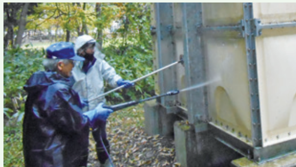
貯水槽外部清掃 作業中 (那珂川8期別荘地)
