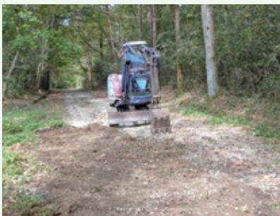
砂利道補修工事 作業中 (グレートハイランド別荘地)
