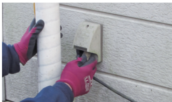
ヒーター線の差込作業
