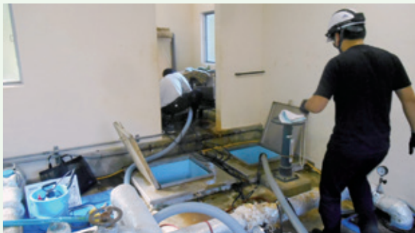
貯水槽清掃 作業中 (レークサイド別荘地)
