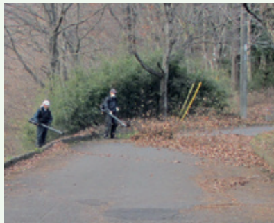
落葉清掃 作業中 (那珂川別荘地)
