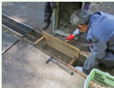
側溝補修工事 作業中 (那珂川18期別荘地)
