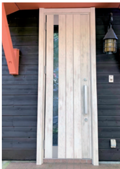
工事完了 玄関ドア
