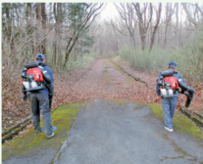
落葉清掃 作業中 (第2緑泉苑別荘地)
