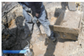
給水管漏水修理・維持管理
