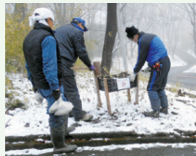
滑り止め用砂箱設置 (バケーションランド別荘地)
