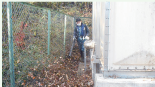
水道施設内落葉清掃 作業中 (グレートハイランド別荘地)
