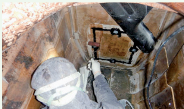
浄化槽内部の補修工事 作業中
