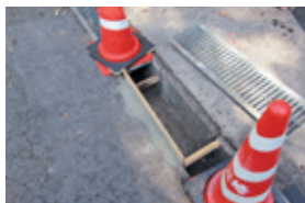
側溝清掃・補修
