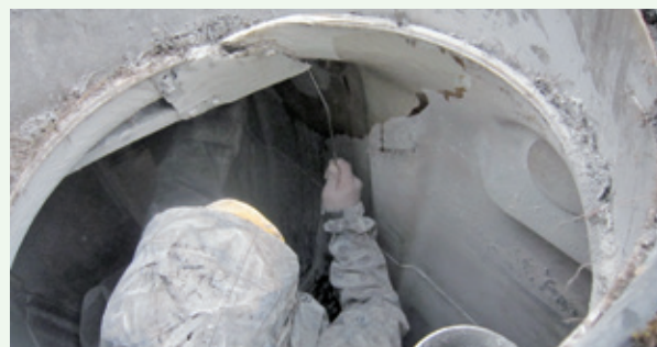
浄化槽内部修繕工事 作業中
