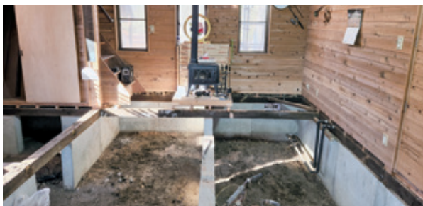
床解体工事 作業中
