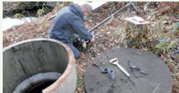
浅井戸水中ポンプ交換工事 作業中 (那珂川8期別荘地)
