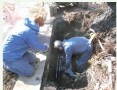
送水管漏水修理工事 作業中 (景勝苑別荘地)
