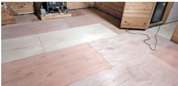
コンパネ敷き工事 作業中
