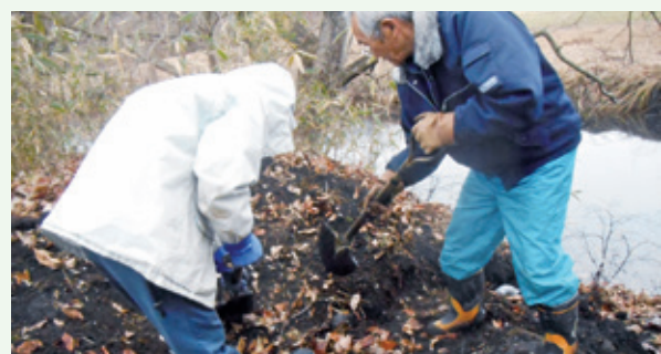
管末バルブ修理工事 作業中 (レークサイド別荘地)
