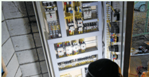
水源制御盤更新工事 作業中 (景勝苑別荘地)
