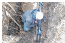
給水管漏水修理・維持管理
