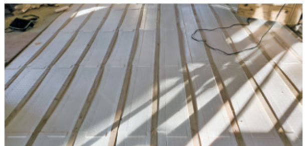
床断熱材敷き工事 作業中
