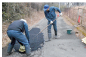
道路補修・清掃
