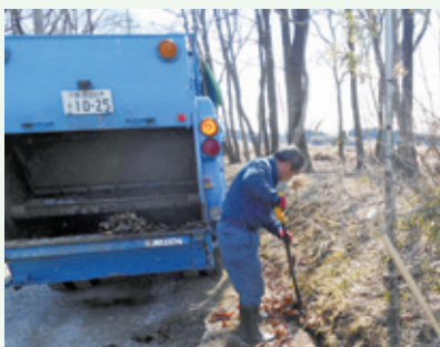
側溝清掃 作業中 (第2緑泉苑別荘地)
