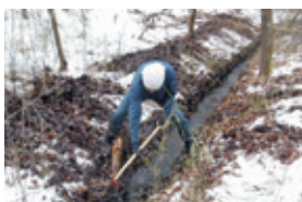
側溝清掃・補修
