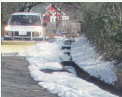
除雪作業 作業中 (桜台別荘地)
