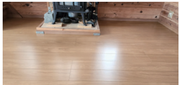
床張替え工事 完了
