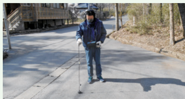
漏水調査 作業中 (グレートハイランド別荘地)
