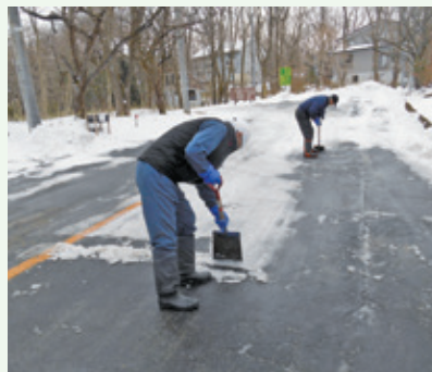
融雪作業 作業中 (バケーションランド別荘地)
