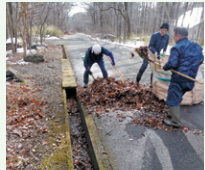
側溝清掃 作業中 (上の原高原別荘地)
