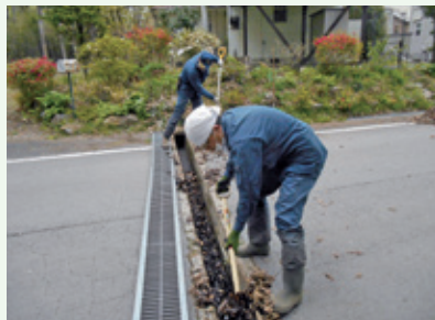
側溝清掃作業中 (グレートハイランド別荘地)
