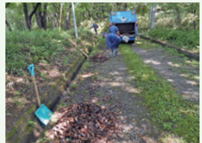
側溝清掃作業中 (那珂川別荘地)
