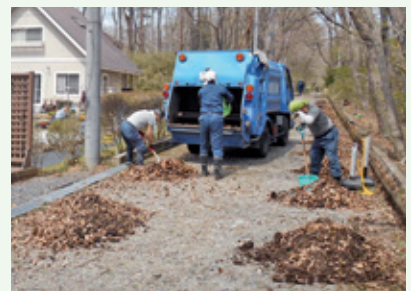
側溝清掃作業中 (第2緑泉苑別荘地)
