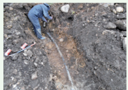
送水管漏水修理工事作業中 (景勝苑別荘地)
