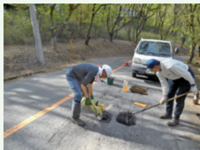
道路補修工事業中 (バケーションランド別荘地)
