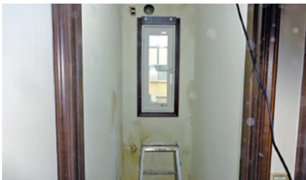
クロス張替え工事 作業中
