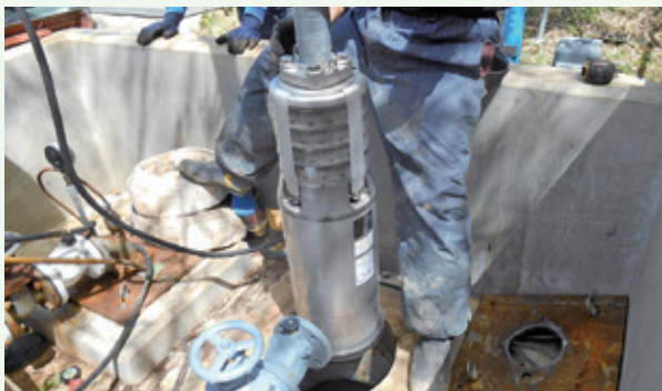
水源送水ポンプ交換工事作業中 (令和5年4月13日 那珂川別荘地)
