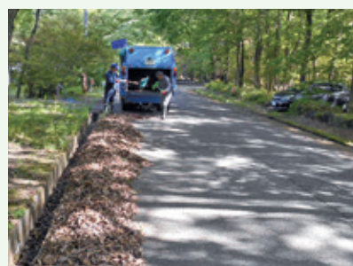
側溝清掃作業中 (上の原高原別荘地)
