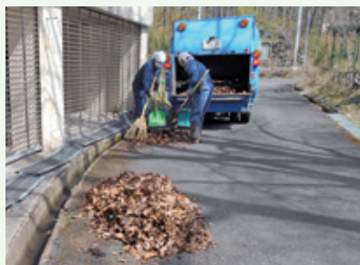
側溝清掃作業中 (レークサイド別荘地)
