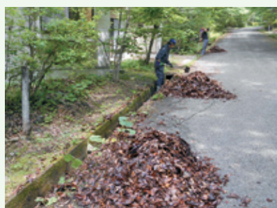
側溝清掃作業中 (上の原高原別荘地)
