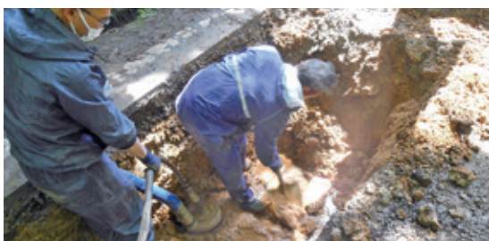
給水管漏水修理・維持管理
