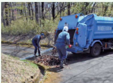
側溝清掃作業中 (吉野台別荘地)
