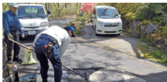
道路補修・清掃
