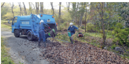
側溝清掃・補修
