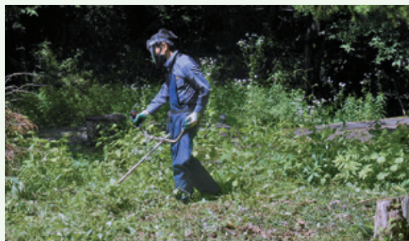
水道施設の草刈り作業中 (長南寺別荘地)
