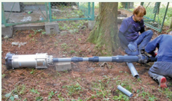
水源送水ポンプ交換工事作業中 (令和5年5月26日 景勝苑別荘地)
