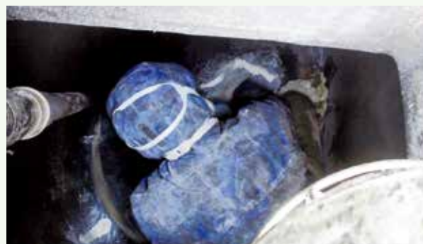
浄化槽内部修繕工事作業中
