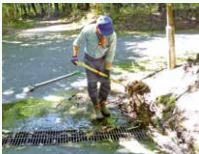
側溝清掃作業中 (吉野台別荘地)
