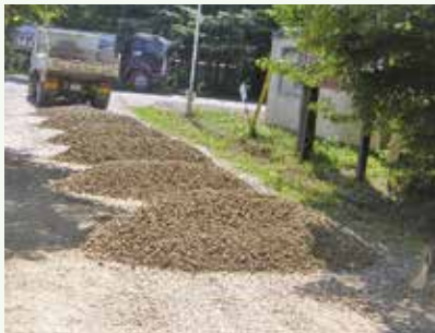
道路補修工事作業中 (景勝苑別荘地)
