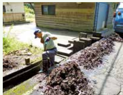
側溝清掃作業中 (バケーションランド別荘地)
