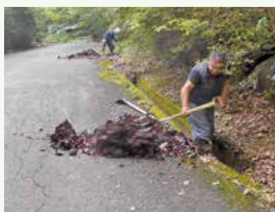
側溝清掃作業中 (上の原高原別荘地)
