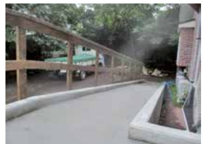
手摺を設置して工事完了
