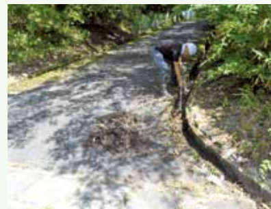
側溝清掃作業中 (桜台別荘地)
