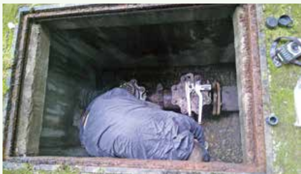
水道施設内の改修工事作業中 (景勝苑別荘地)
