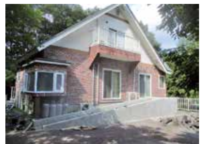
外側コンクリート打設
