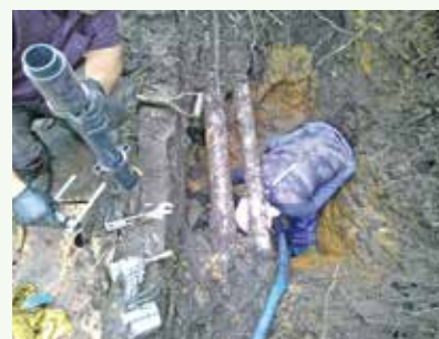
給水管漏水修理工事作業中 (レークサイド別荘地)
