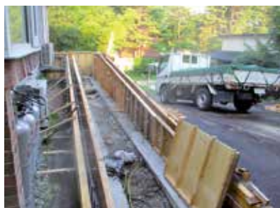
型枠設置工事 作業中
