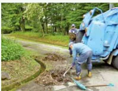
側溝清掃作業中 (那珂川8期別荘地)
