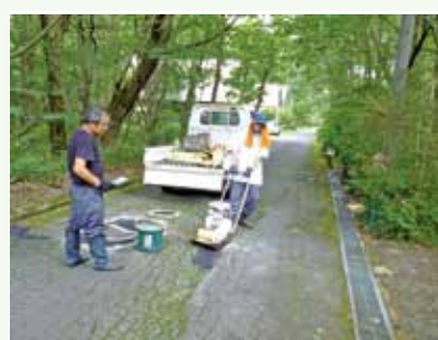
道路補修工事作業中 (バケーションランド別荘地)
