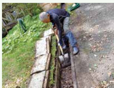
側溝清掃作業中 (上の原高原別荘地)
