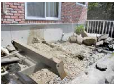
掘削工事 作業中
