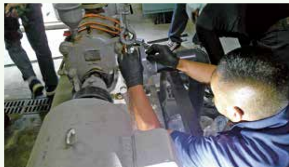
タービンポンプフード弁交換工事作業中 (吉野台別荘地)
