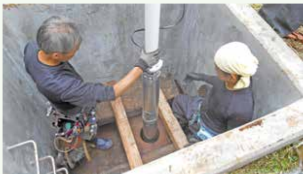
水源井戸ポンプ更新工事作業中 (那珂川別荘地)
