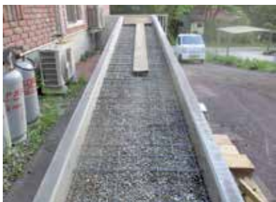
ワイヤーメッシュ設置工事 作業中
