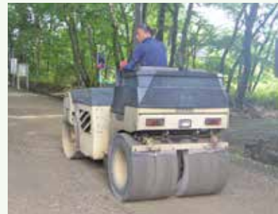
道路補修工事作業中 (那珂川別荘地)
