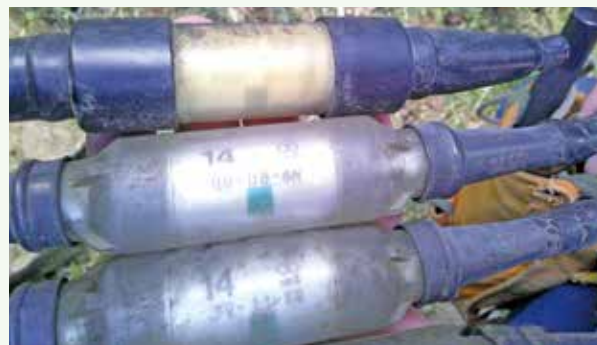
水道施設の電柱のヒューズ交換 (グレートハイランド別荘地)
