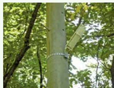
街路灯設置完了 (景勝苑別荘地)
