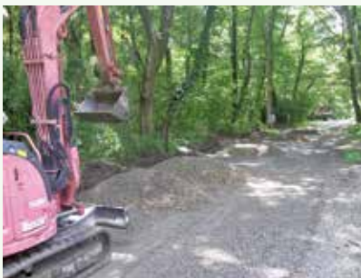
道路補修工事作業中 (第2緑泉苑別荘地)
