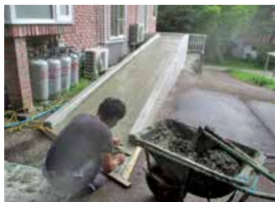
コンクリート流し込み工事 作業中
