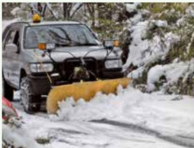
除雪作業 作業中 (レークサイド別荘地)
