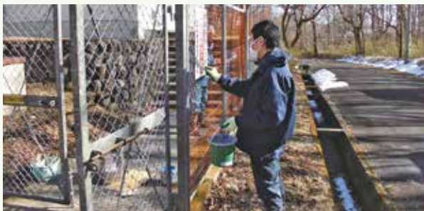
水道施設塗装作業 作業中 (桜台別荘地)
