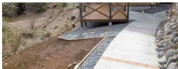
デッキ拡張工事 完了
