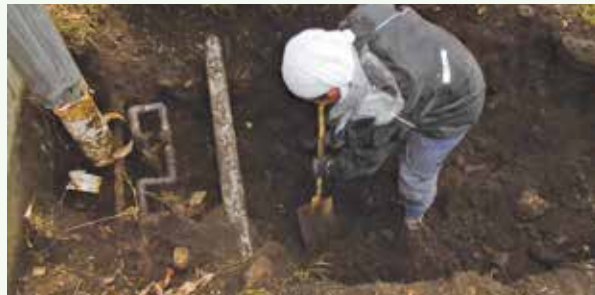
水道施設内漏水修理工事 作業中 (景勝苑別荘地)
