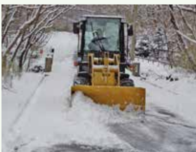
除雪作業 作業中 (上の原高原別荘地)
