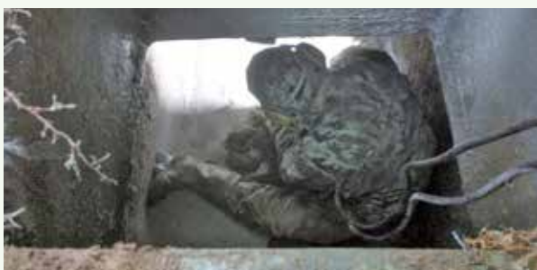
浄化槽内部で作業中
