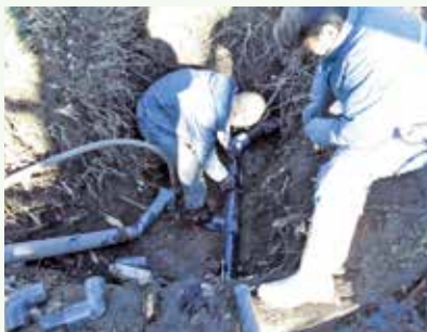
漏水修理工事 作業中 (那珂川別荘地)
