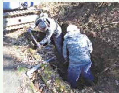
漏水修理工事 作業中 (吉野台別荘地)
