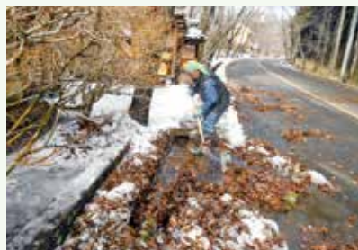
側溝清掃 作業中 (バケーションランド別荘地)
