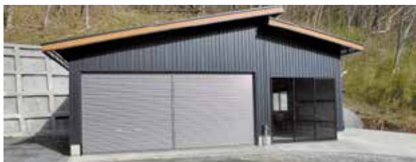
ガレージ新設工事 完了
