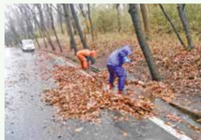
強雨時の側溝清掃 作業中 (バケーションランド別荘地)
