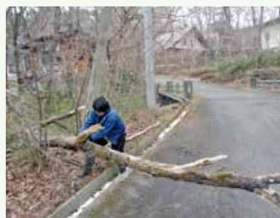
倒木処理 作業中 (上の原高原別荘地)
