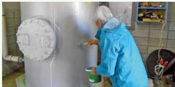
加圧タンク塗装作業 作業中 (景勝苑別荘地)
