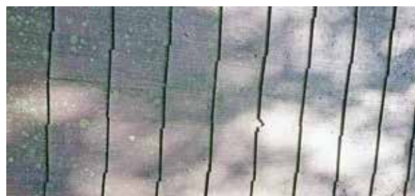
屋根のケバラ修復工事 完了
