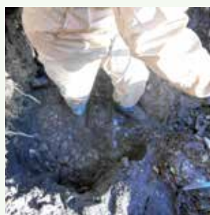
給水管漏水修理
