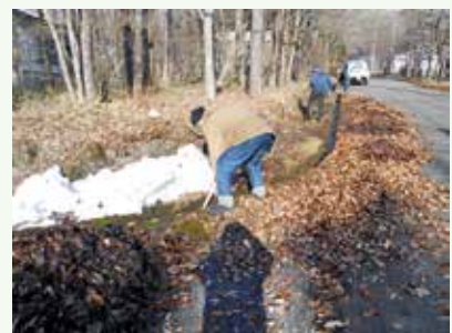
側溝清掃 作業中 (上の原高原別荘地)
