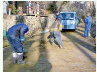
路面苔はがし作業 作業中 (レークサイド別荘地)
