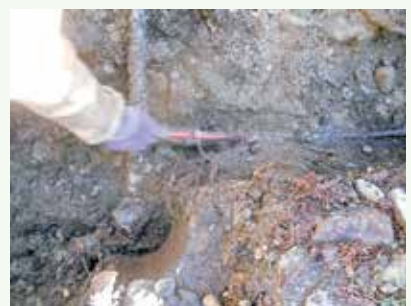
配水管漏水修理工事 作業中 (景勝苑別荘地)
