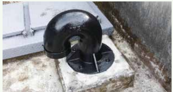
水道施設内塗装工事 完了 (那珂川別荘地)
