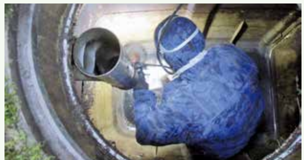
浄化槽内亀裂修繕工事 作業中
