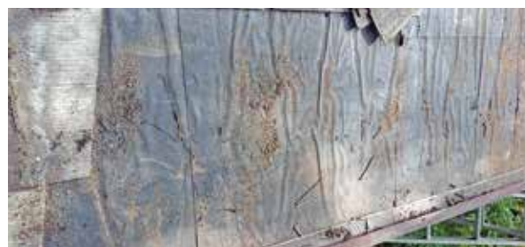
屋根のケバラ修復工事 作業中
