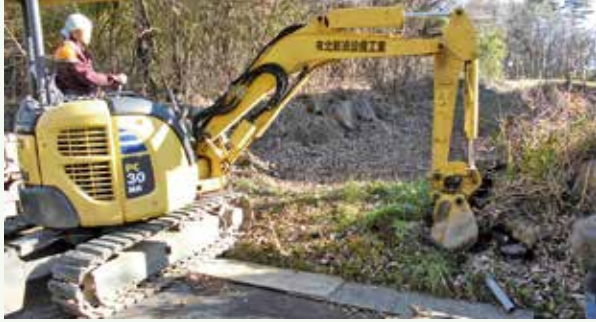
管末バルブ交換工事 作業中 (那珂川8期別荘地)
