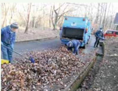
側溝清掃 作業中 (桜台別荘地)
