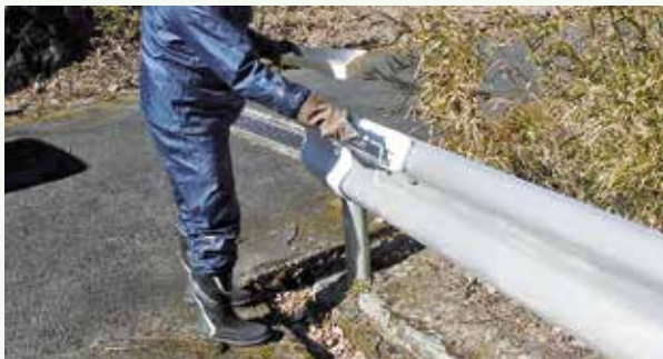
水道施設内塗装工事 作業中 (レークサイド別荘地)
