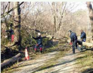
倒木処理 作業中 (景勝苑別荘地)
