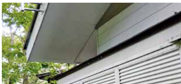
屋根の修復工事 完了
