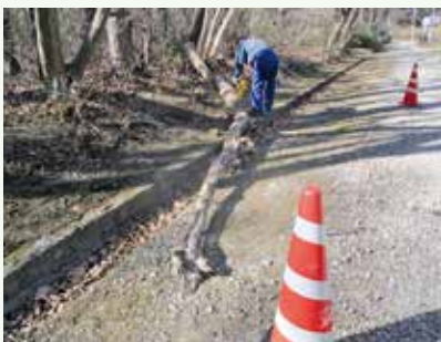
倒木処理 作業中 (那珂川別荘地)
