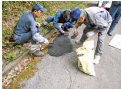
道路補修工事 作業中 (桜台別荘地)
