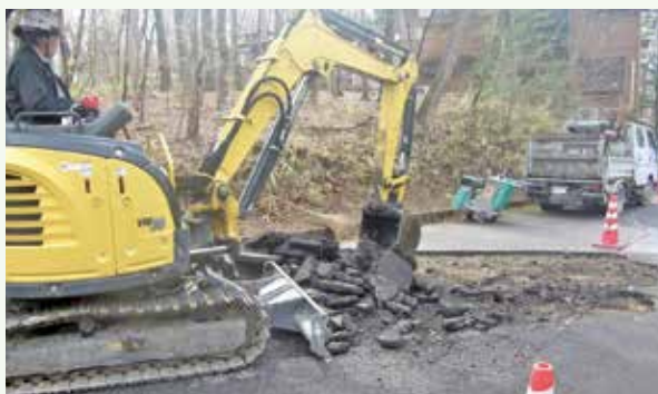
道路補修工事
