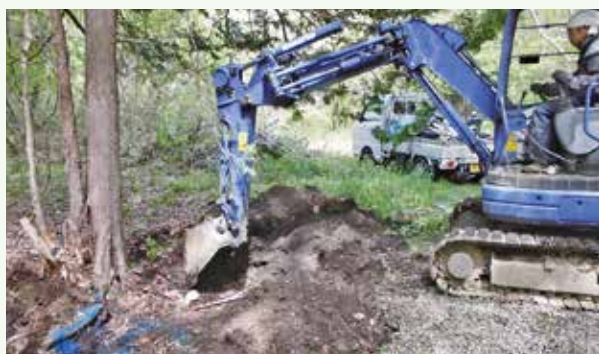
漏水修理工事
