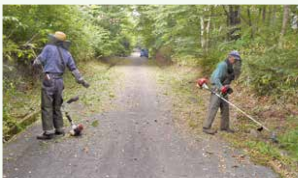
道路路肩の草刈り
