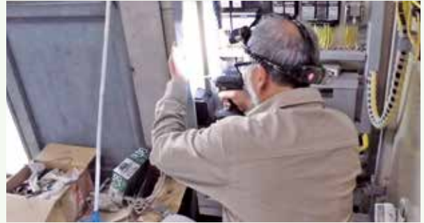
制御盤避雷器設置工事 作業中 (長南寺別荘地)
