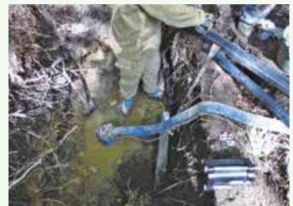
漏水修理工事 作業中 (景勝苑別荘地)
