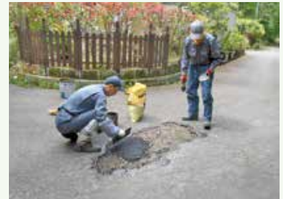
道路補修工事 作業中 (吉野台別荘地)
