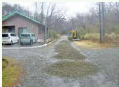
道路補修工事 作業中 (景勝苑別荘地)
