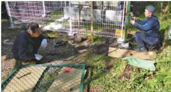
貯水槽周りフェンス設置工事 作業中 (那珂川8期別荘地)
