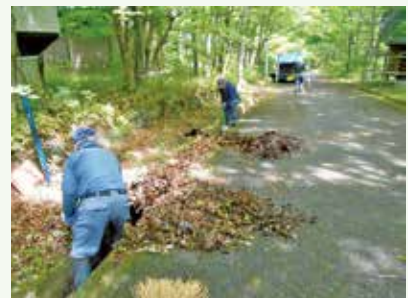
側溝清掃 作業中 (上の原高原別荘地)
