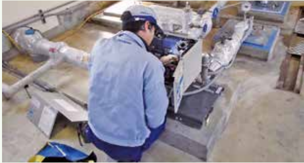
配水池フレッシュポンプ故障復旧作業 作業中 (レークサイド別荘地)
