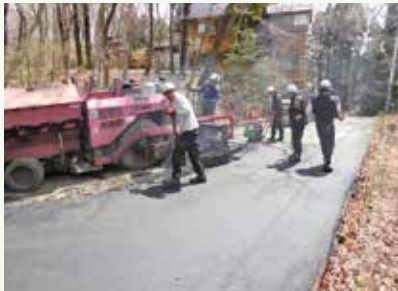
道路補修工事 作業中 (那珂川別荘地)
