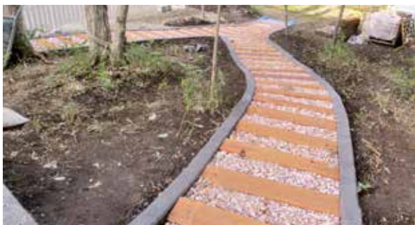
遊歩道整備とドックラン整備 作業中
