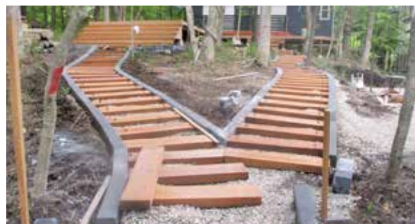
遊歩道整備工事 作業中
