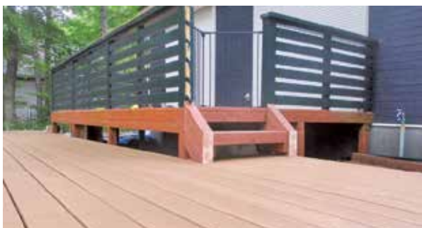
ウッドデッキ拡張工事 作業中
