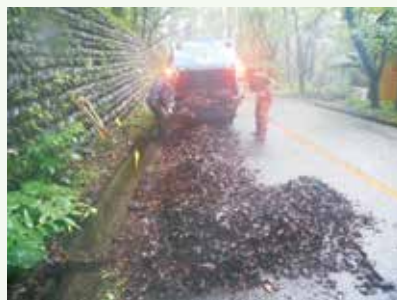
豪雨時の側溝清掃 作業中 (バケーションランド別荘地)
