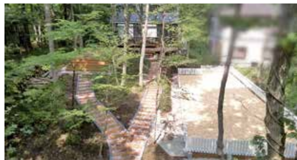
外構工事 完了
