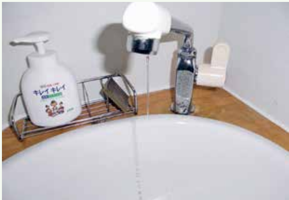
水道の凍結防止のために、細く水を流す例 (水量の目安は太さ3mm位)
