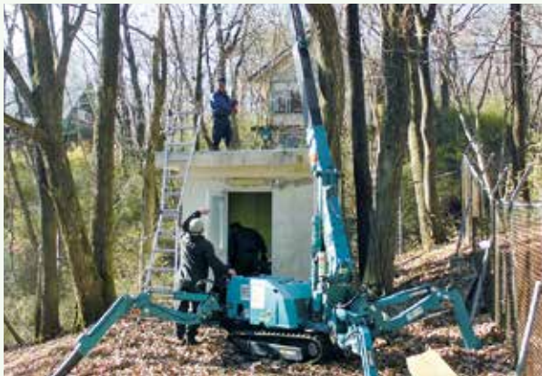
水源井戸ポンプ交換工事 作業中 (桜台別荘地)
