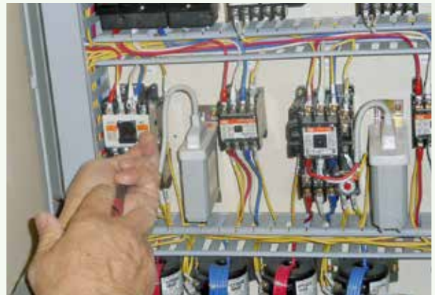
リレー交換工事 作業中 (桜台別荘地)
