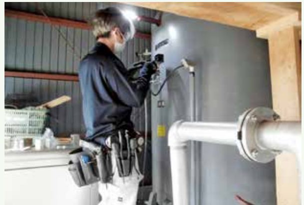
加圧タンク圧カススイッチ交換工事 作業中 (グレートハイランド別荘地)
