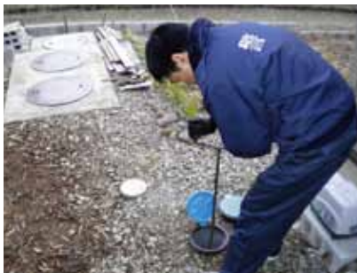
バルブ開栓作業
