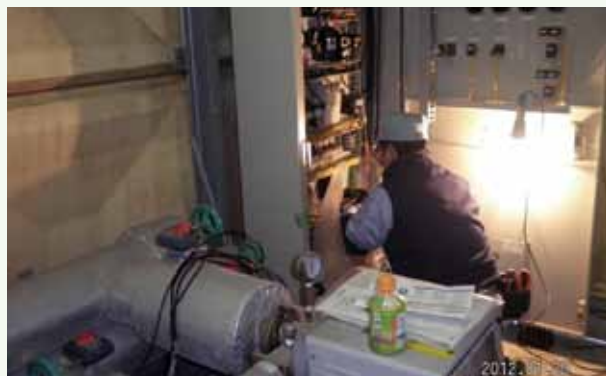
制御盤メンテナンス修理作業 (那珂川)
