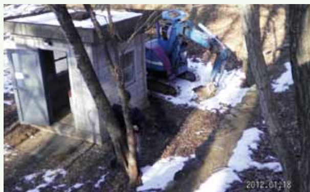
漏水箇所掘削作業 (吉野台)
