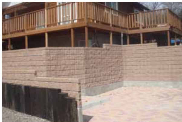
化粧ブロックインターロッキング敷 施工後
