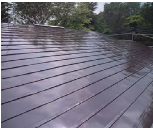
屋根塗装完了
