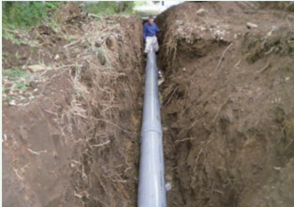
ヒューム管側溝排水設備改修工事（那珂川8期）
