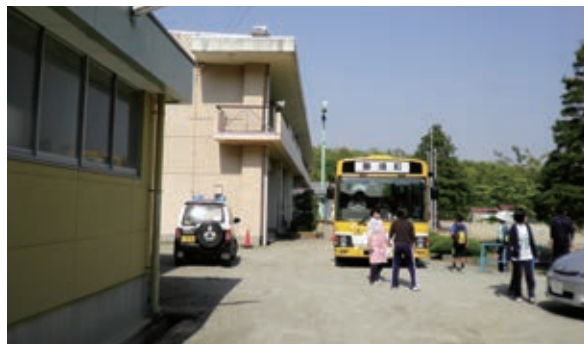
那須町立那須小学校
