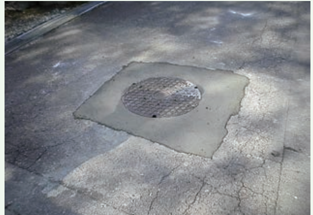
マンホール修繕工事（山吹台9期）
