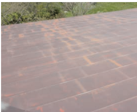
屋根塗装施工前
