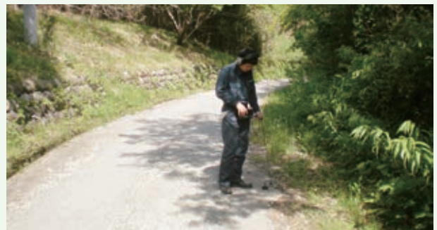
漏水調査（那珂川）
