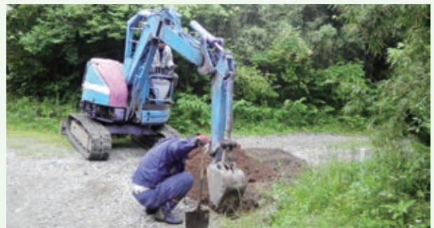
漏水箇所掘削作業（那珂川）
