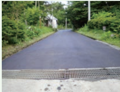
バケーションランド 陽地区道路
