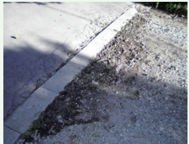
段差補修工事後（グレートハイランド）
