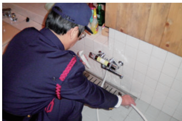
シャワーカラン水抜き作業中
