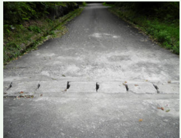
道路補修工事後（バケーションランド）
