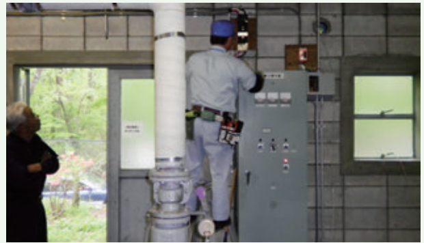
制御盤修繕工事（吉野台）
