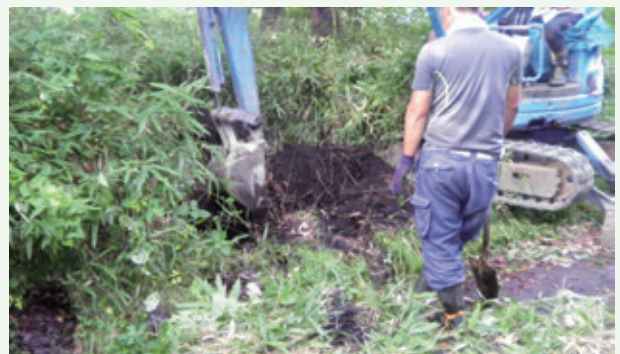
漏水修理工事（吉野台）
