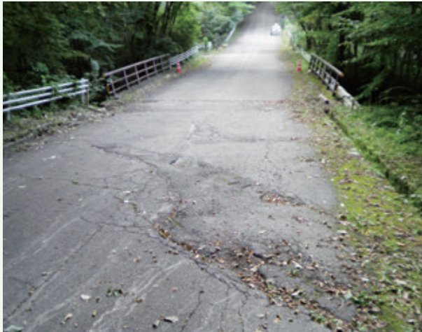
道路修繕舗装工事前（吉野台）
