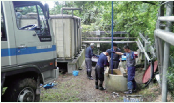
水中ポンプメンテナンス工事（第二緑泉苑）
