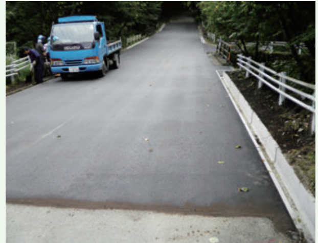
道路修繕舗装工事後（吉野台）
