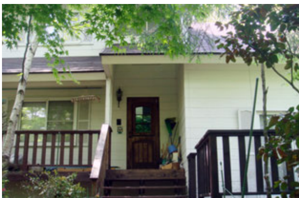
改修工事前（バケーションランド）
