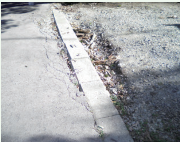
段差補修工事前（グレートハイランド）
