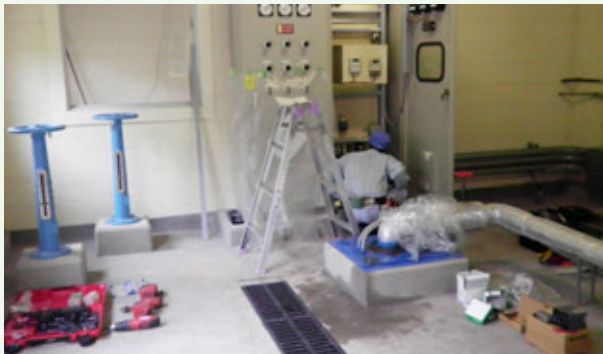
制御盤修繕工事（桜台）
