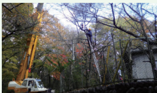
伐採工事（吉野台 配水施設）
