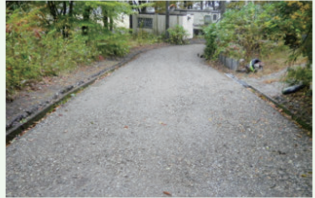
道路修繕工事（第二緑泉苑）
