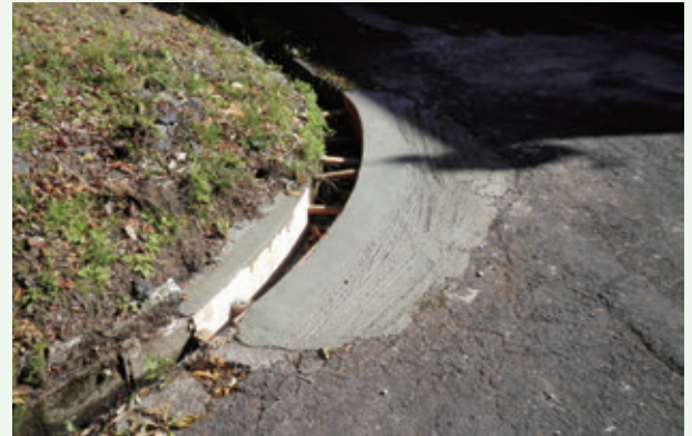
側溝修繕工事（山吹台 9 期）
