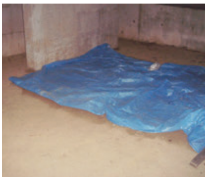
施工工事前（バケーションランド）
