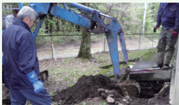
漏水修理工事（景勝苑 配水施設）
