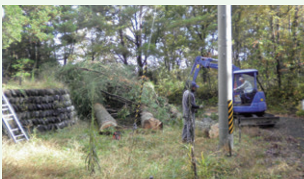
伐採工事（鷹の台 配水施設）
