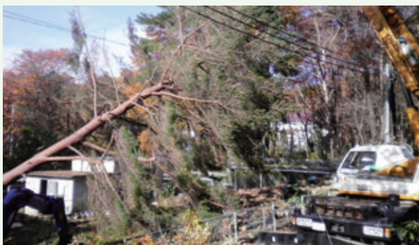
伐採工事（第二緑泉苑 水道施設）
