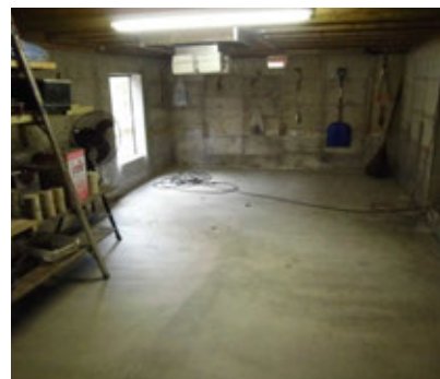
工事完了後（バケーションランド）
