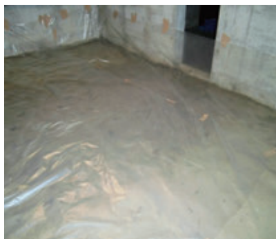
工事中（バケーションランド）
