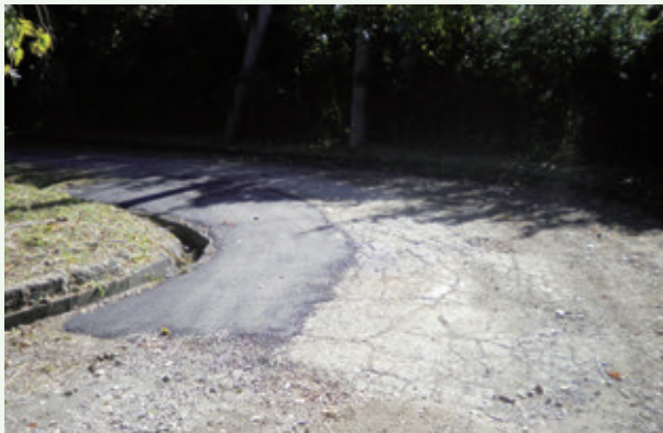
道路修繕舗装工事（那珂川）
