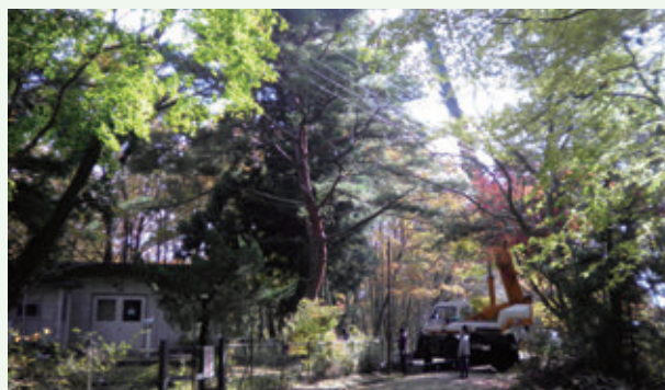
伐採工事（景勝苑 配水施設）
