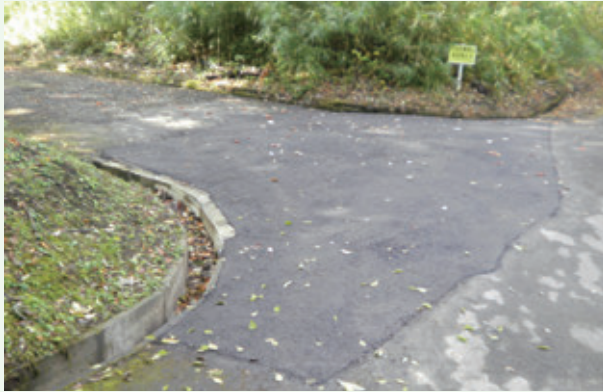
道路修繕舗装工事（那珂川 8 期）
