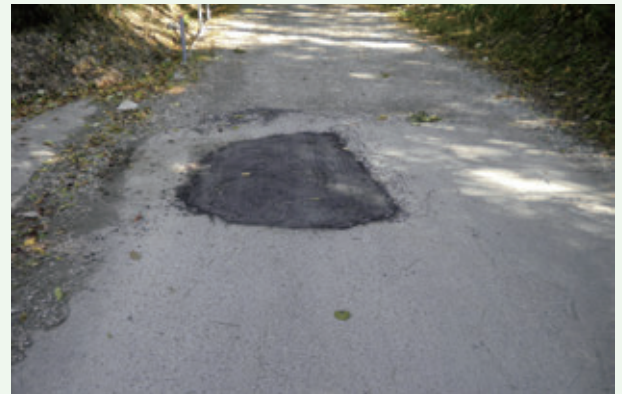
道路陥没箇所修繕工事（那珂川）
