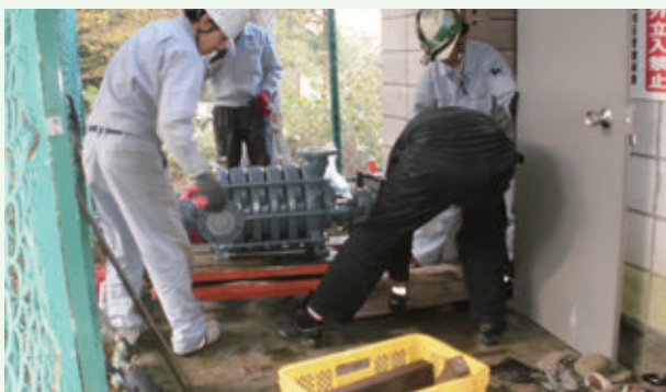
送水ポンプ一式交換工事（景勝苑 水源施設）
