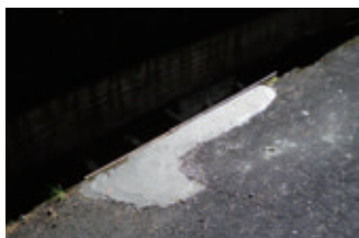
側溝補修
