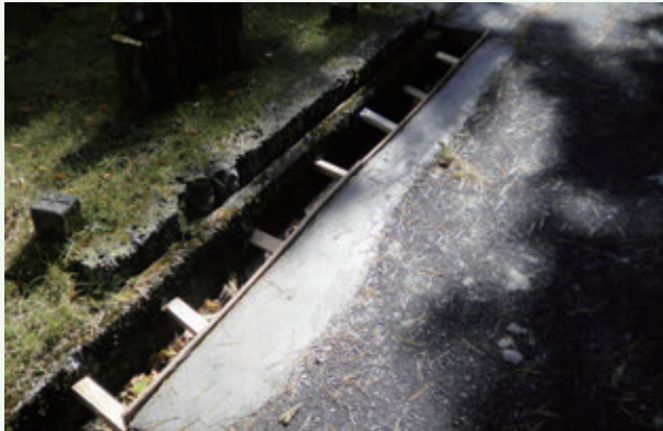
側溝修繕工事（山吹台 9 期）
