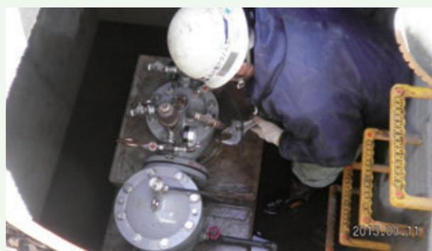
減圧弁装置のメンテナンス修理工事（バケーションランド）
