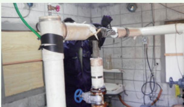
給水ポンプの給水管修理と止水バルブ類交換工事
