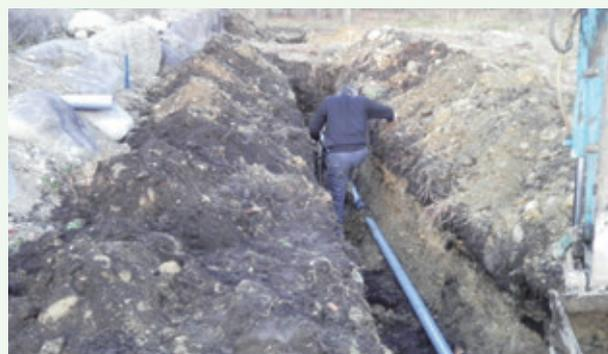
送水管漏水修理工事（景勝苑）
