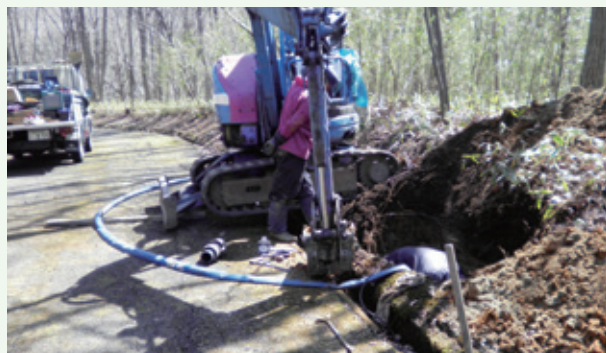
配水管漏水修理工事（吉野台）
