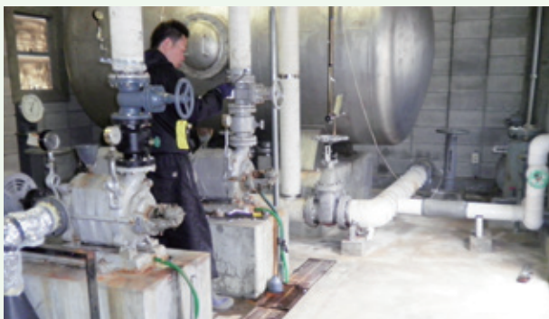
給水ポンプの止水バルブ類交換工事（吉野台）
