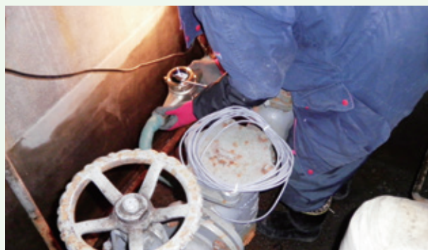
量水器装置の交換工事（那珂川8期）
