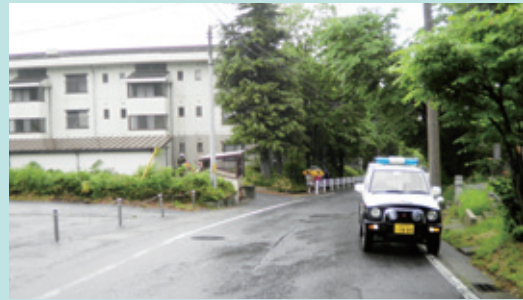
那須町立那須小学校
