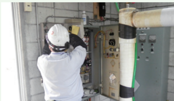
制御盤内のメンテナンスと修理工事（那珂川8期）
