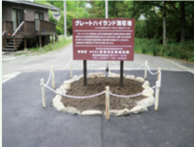
ロータリー工事
