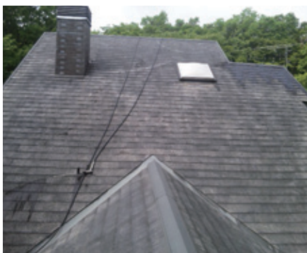
屋根塗装施工前
