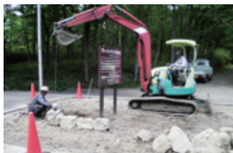
ロータリー工事
