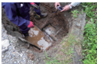
水道管漏水修理工事
