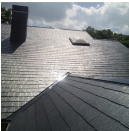
屋根塗装施工完了
