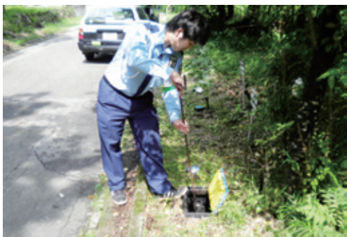
水道元栓の開閉作業
