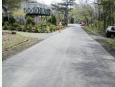
道路補修工事
