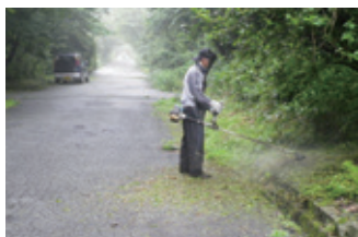
道路路肩の草刈り
