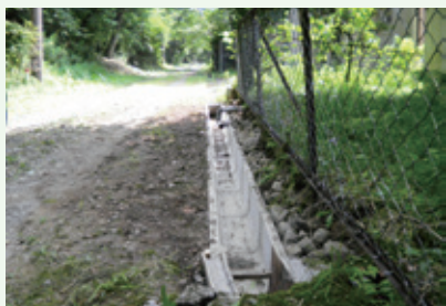
側溝補修工事
