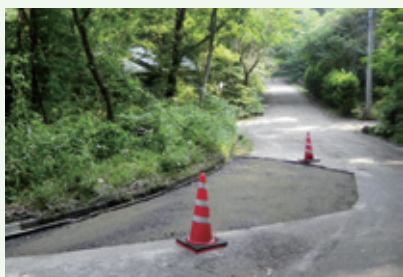
道路修繕工事中
