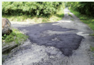
道路補修工事
