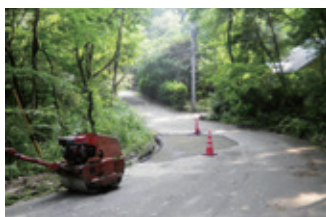
道路補修工事
