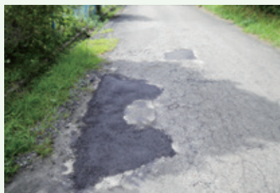
道路補修工事
