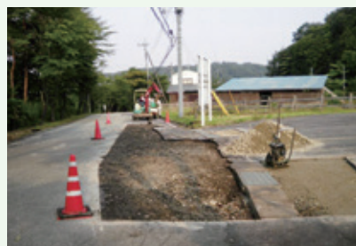
道路修繕工事中
