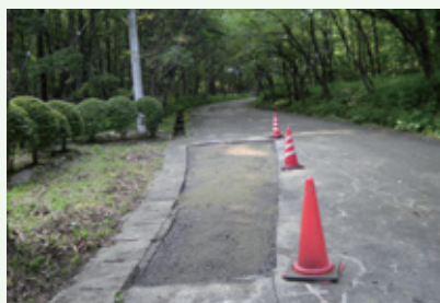
道路修繕工事中
