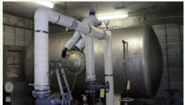
配水施設の圧力タンクのメンテナンス（吉野台）
