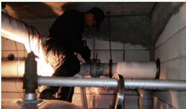
配水管漏水修理工事（景勝苑）
