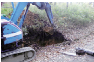
漏水修理工事
