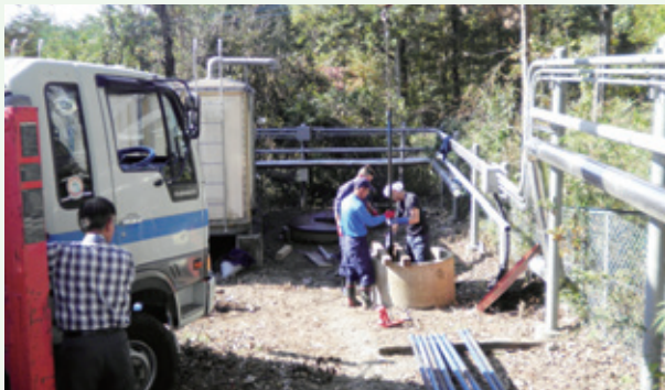
配水施設の水中ポンプのメンテナンス（第二緑泉苑）
