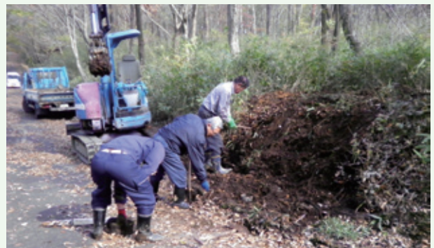
配水管止水バルブ修理工事（吉野台）
