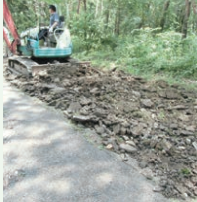
湯の里村道路修繕
