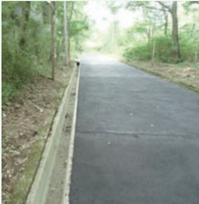
グレートハイランド舗装工事後
