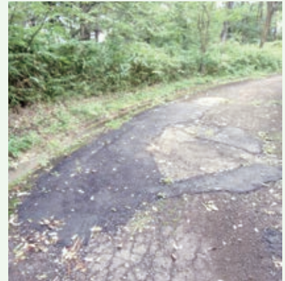
長南寺道路修繕後
