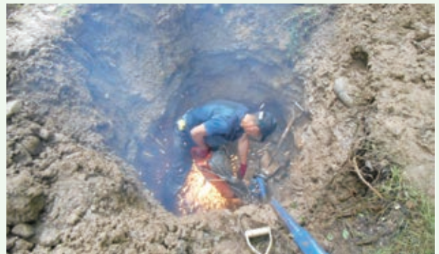
送水管漏水修理工事（景勝苑）
