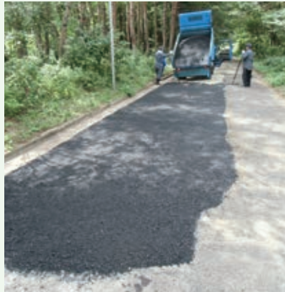
湯の里村道路修繕後
