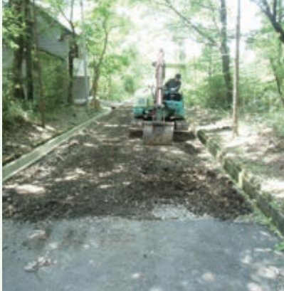
グレートハイランド舗装工事
