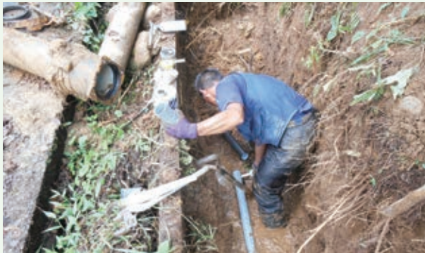
配水管漏水修理工事（八方高原）
