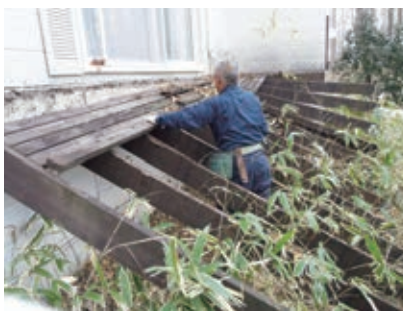
古いウッドデッキの解体作業
