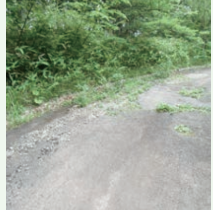
長南寺道路修繕
