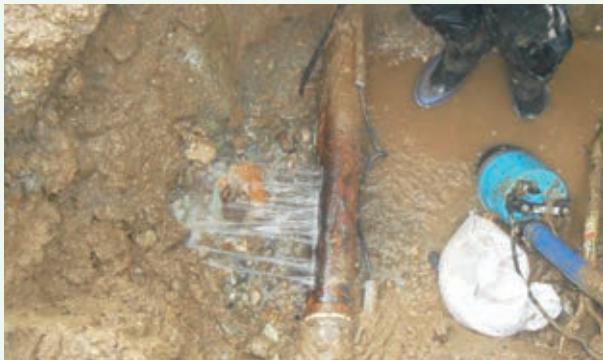
送水管漏水修理工事（景勝苑）
