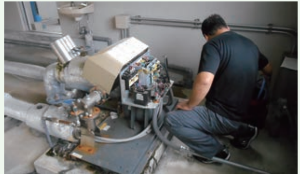
給水モーターポンプ修繕工事（バケーションランド）
