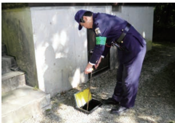
水道元栓の開閉作業
