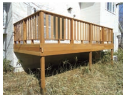
ウッドデッキ完成
