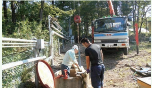
井戸ポンプ交換工事（第二緑泉苑）
