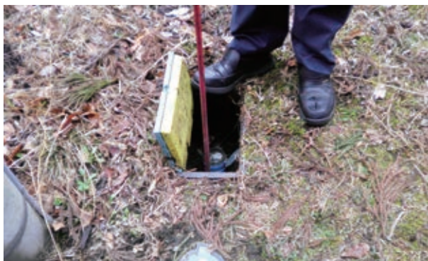
バルブ開栓作業
