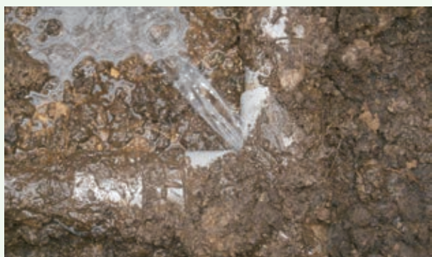
配水管の漏水修理工事 2月（那珂川）
