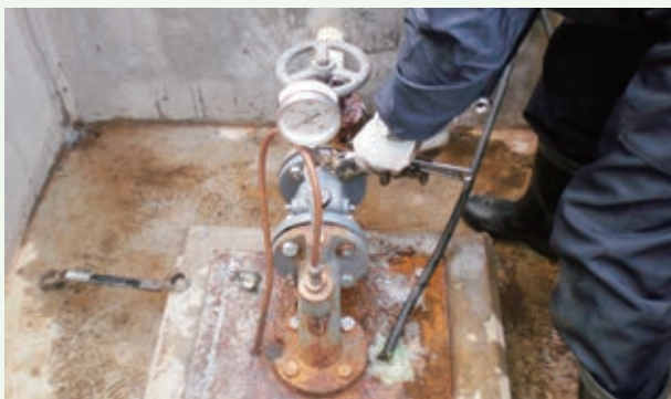
送水管逆止弁の交換工事 12月（那珂川）
