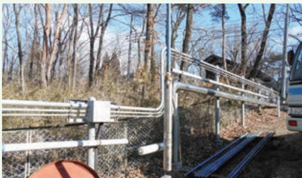
井戸水中ポンプの交換工事 1月（第二緑泉苑）
