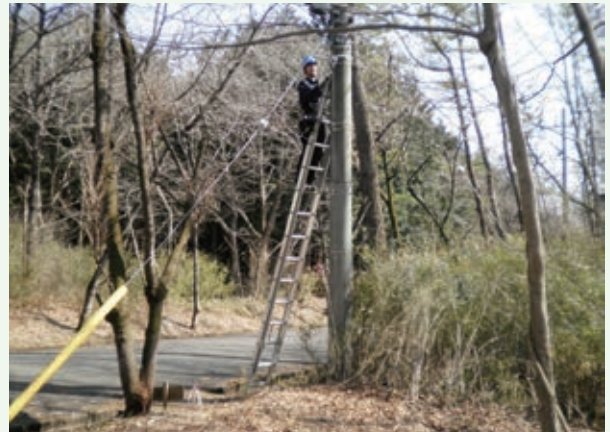
街路灯交換（バケーションランド）
