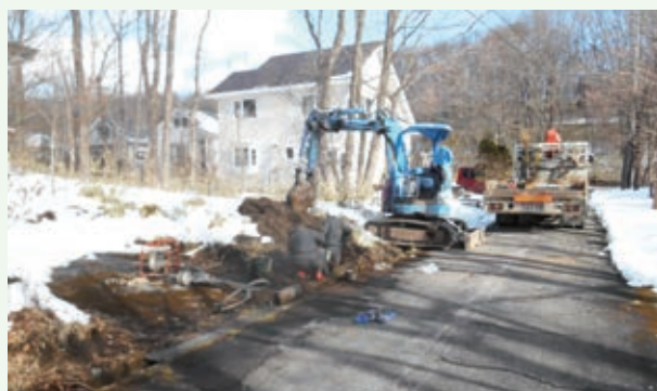
配水管の漏水修理工事 2月（バケーションランド）
