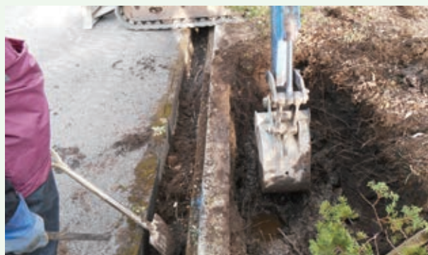
配水管の漏水修理工事 12月（那珂川）
