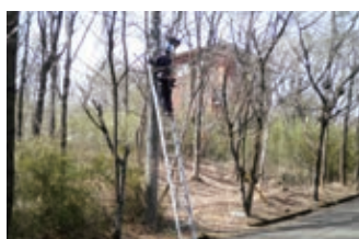
LED街路灯交換
