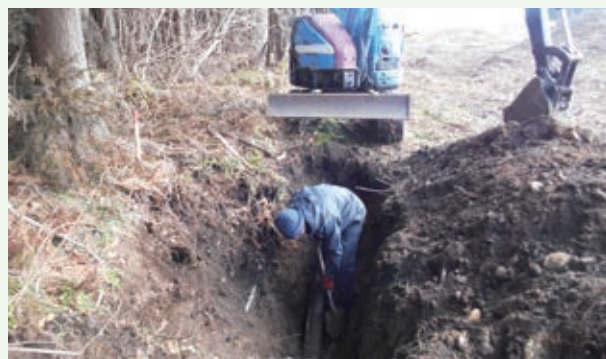
水源送水管の漏水修理工事 2月（景勝苑）
