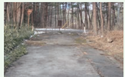
作業完了（湯の里村）
