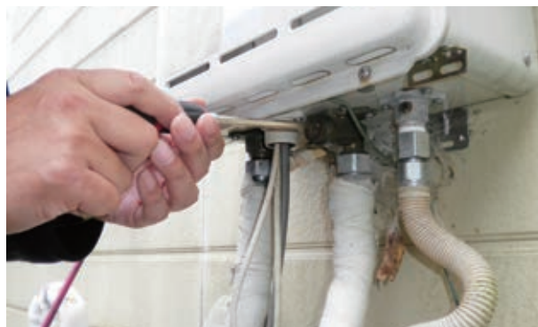
給湯器水出し作業
