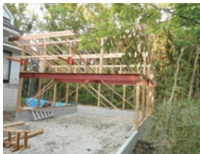
駐車場 工事中
