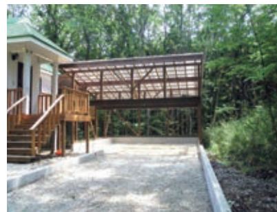
駐車場 工事完了
