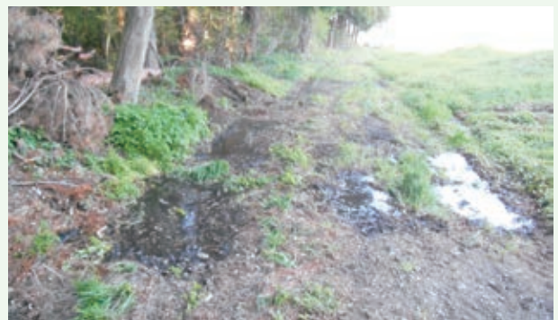
水源送水管の漏水修理工事4月（景勝苑）
