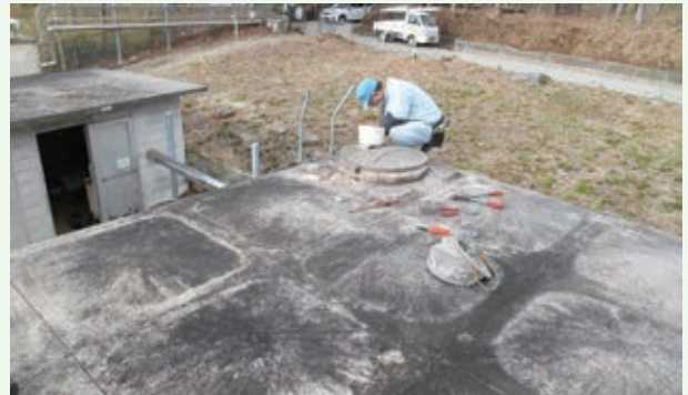
貯水槽水位調節センサー修繕工事4月（第二緑泉苑）
