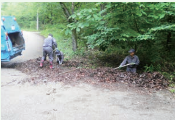
側溝清掃作業中（桜台）
