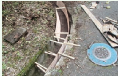
バケーションランド側溝補修工事中
