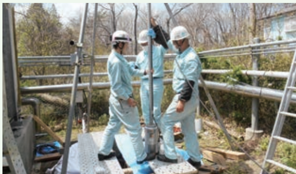
浅井戸水中ポンプの交換工事4月（第二緑泉苑）
