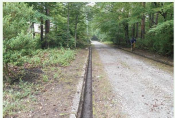
側溝清掃作業後（景勝苑）
