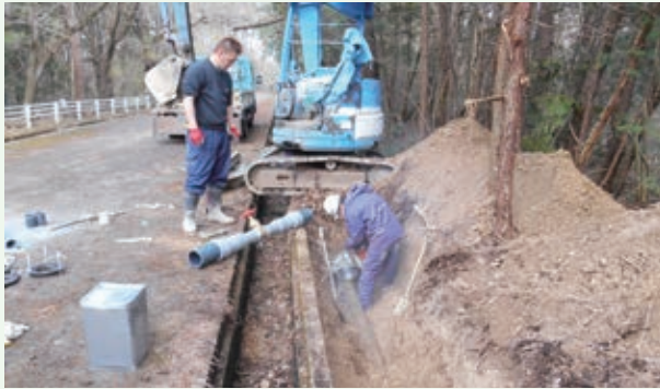
水道管止水バルブの交換工事4月（八方高原）
