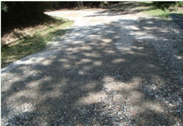
砂利入れ工事後（グレートハイランド）
