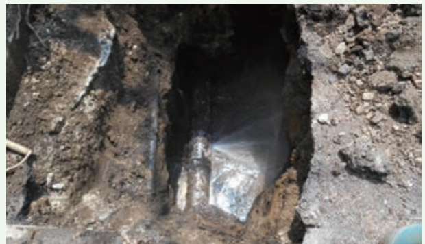
配水管の漏水修理工事6月（豊原）
