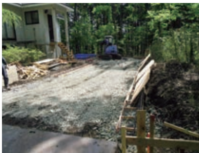
駐車場 工事前
