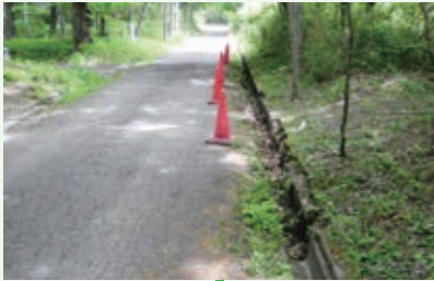
グレートハイランド側溝補修工事前
