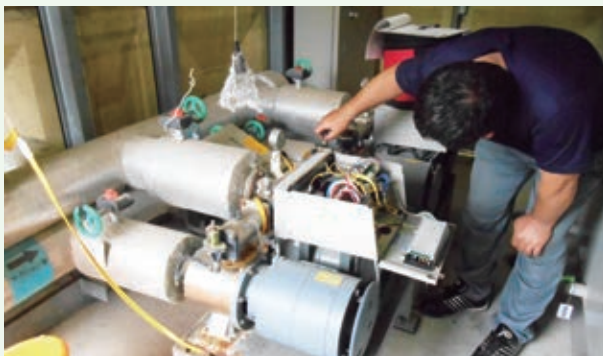
配水ポンプのメンテナンス工事5月（那珂川）
