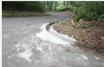
バケーションランド側溝補修工事後
