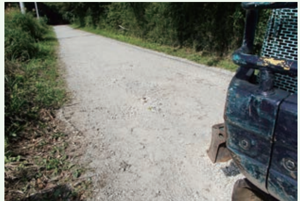
砂利入れ工事後（第二緑泉苑）
