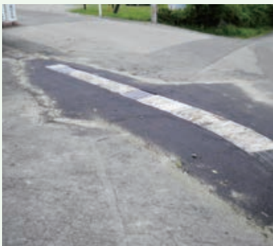
バケーションランド入口補修工事後
