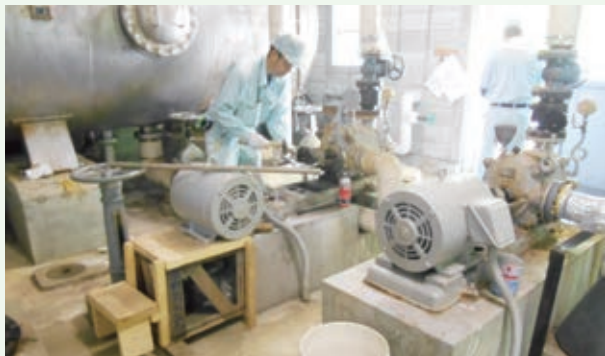
給水ポンプの修繕工事（吉野台）
