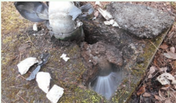
配水管漏水修理工事（上の原）
