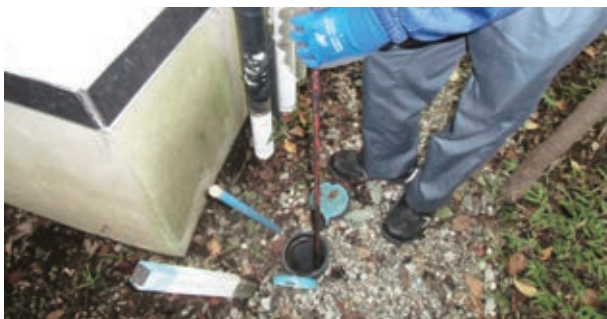
水道元栓の開閉作業
