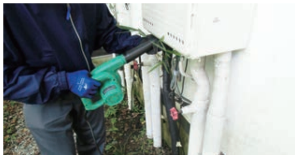
給湯器の水抜き作業
