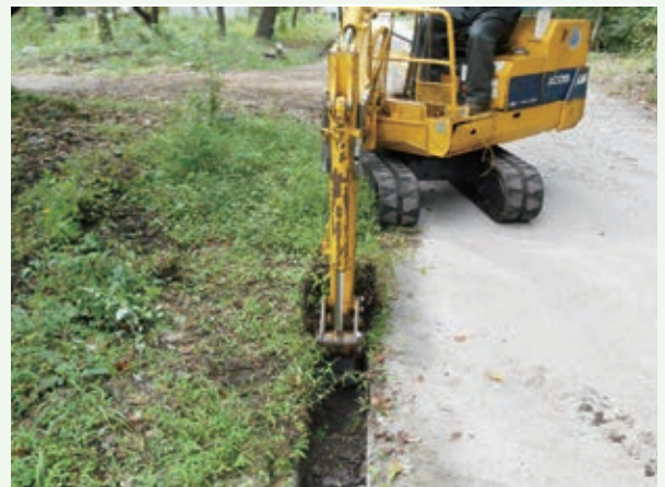
台風通過後の側溝清掃作業（景勝苑）
