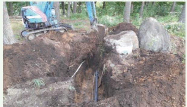
水源送水管漏水修理工事（景勝苑）
