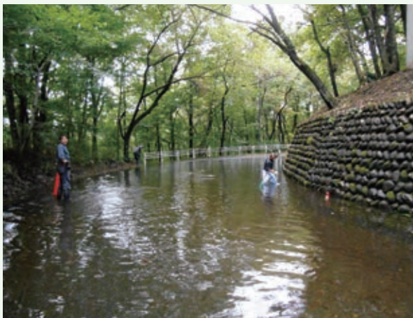
台風通過後の作業（バケーションランド）
