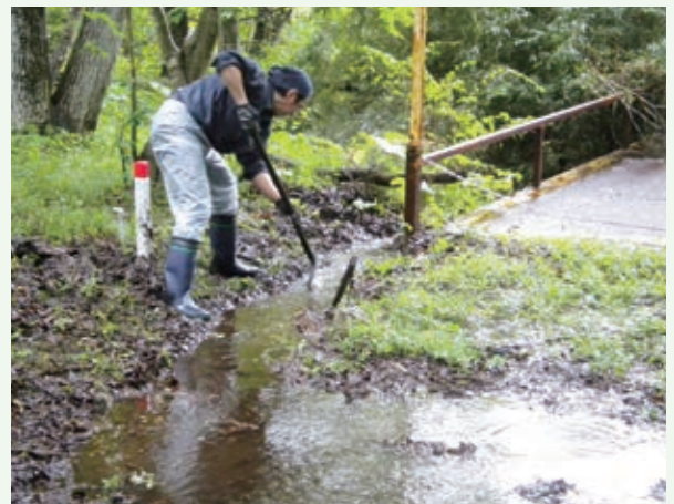
台風通過後の作業（バケーションランド）
