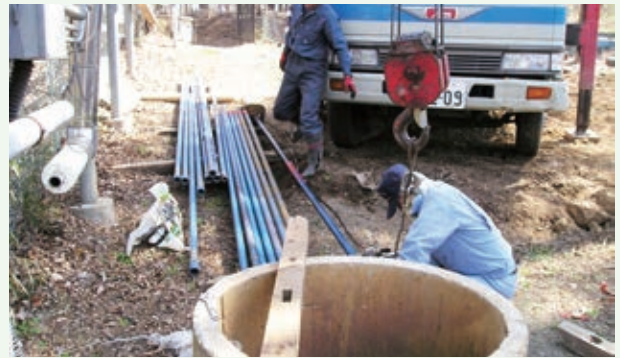
井戸ポンプ交換工事（第二緑泉苑）
