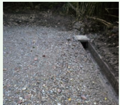
景勝苑雨水処理工事後
