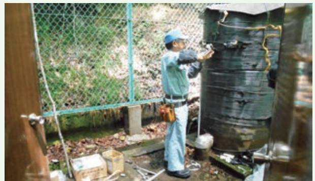
圧力タンク装置の修繕工事（那須の里）
