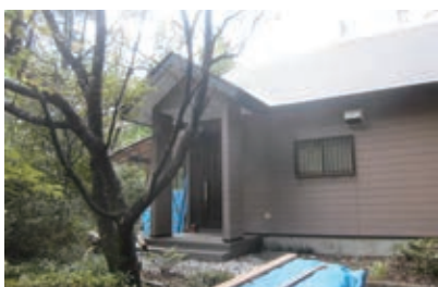
工事前の外観
