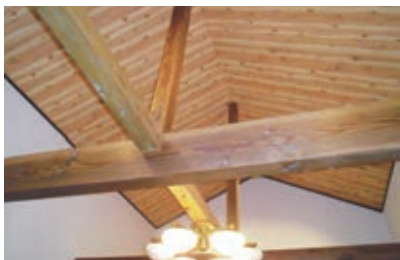
吹き抜け張替工事完了
