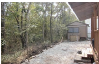
敷地内土留め工事完了
