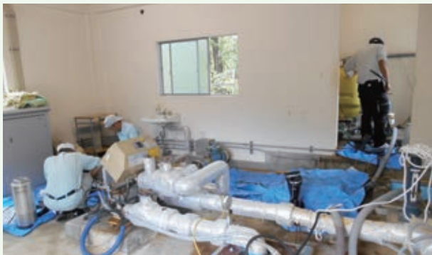
給水ポンプの修繕工事と貯水槽清掃（レークサイド）
