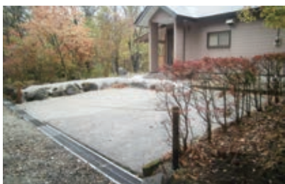
駐車場工事完了
