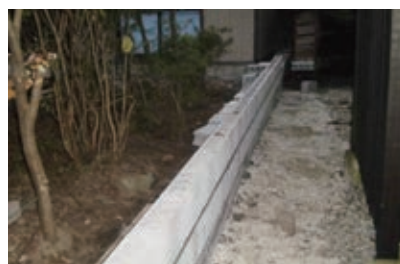
隣地との塀設置工事完了
