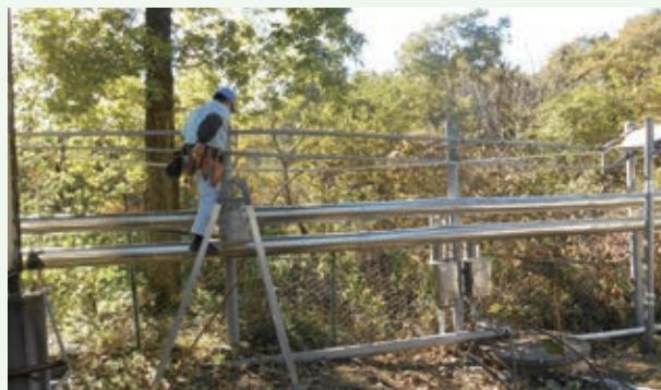
ケーブル線の修繕工事（第二緑泉苑）
