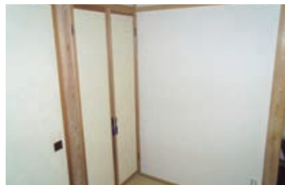
襖他張替工事完了
