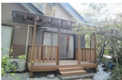
ウリン材サンデッキ工事完了
