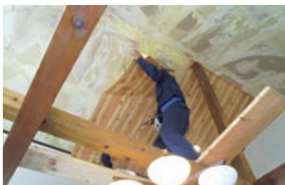
吹き抜け張替工事作業中
