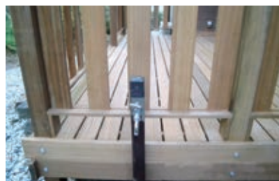
散水栓設置完了
