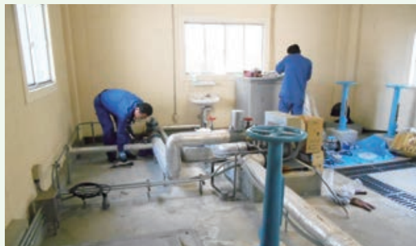
量水器ユニットの交換工事（桜台）
