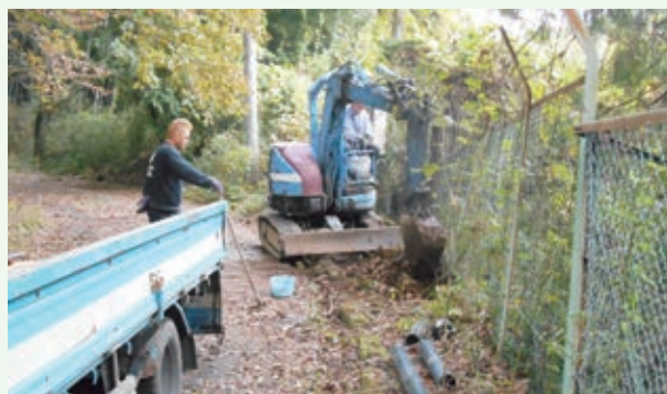
配水管の漏水修理工事（豊原）
