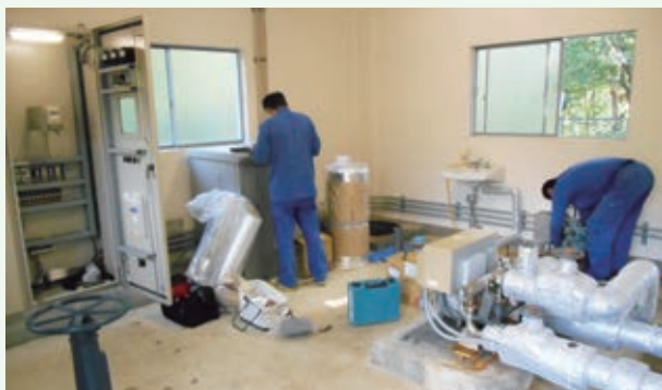
量水器ユニットの交換工事（レークサイド）
