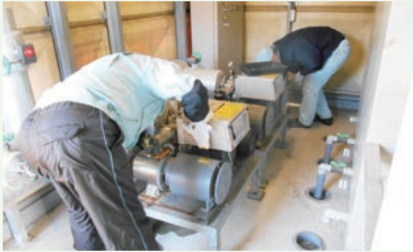
給水ポンプの修繕工事（那珂川）
