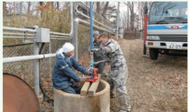
深井戸水中ポンプの交換工事（第二緑泉苑）
