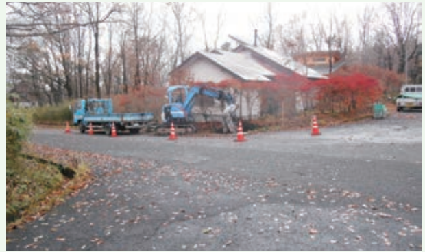
配水管の漏水修理工事（上の原高原）
