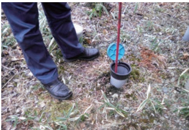
抜バルブ栓の開閉作業
