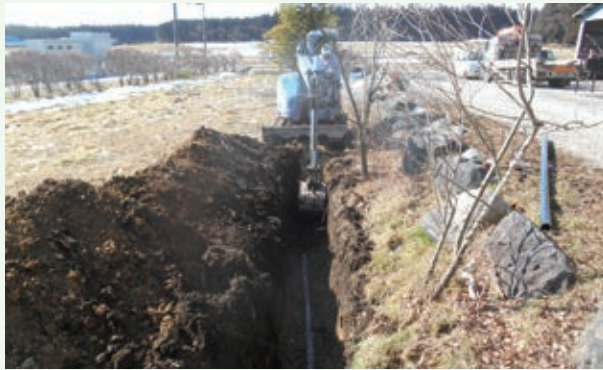
配水管の漏水修理工事（景勝苑）
