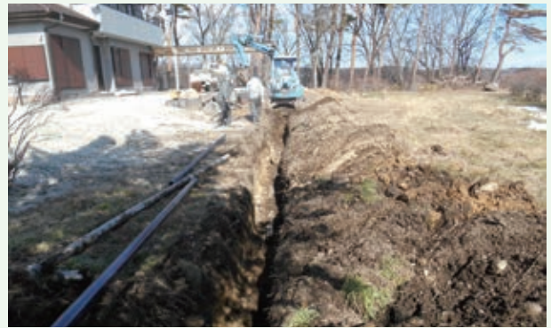
配水管の漏水修理工事（景勝苑）
