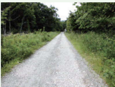
砂利入れ工事後（第二緑泉苑）
