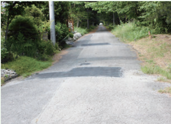
道路補修工事後（湯の里村）
