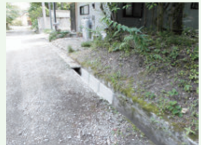
側溝補修工事後（那珂川）
