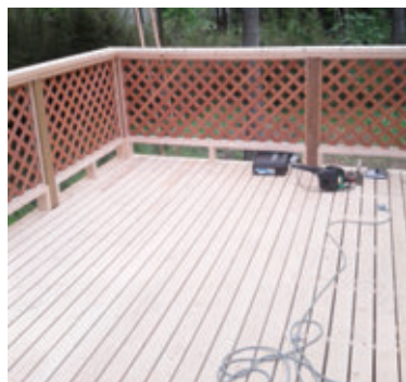
サンデッキ工事中
