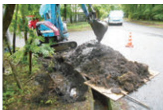
漏水修理工事
