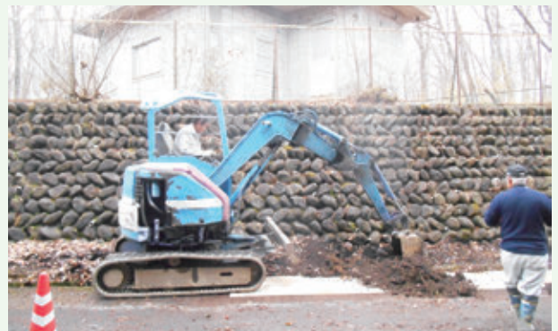
配水管の敷設替え修繕工事（吉野台）
