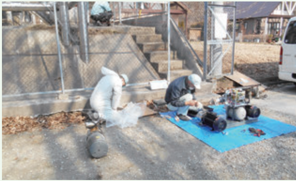
給水ポンプユニットの交換工事（那珂川）
