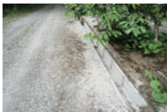
側溝補修工事
