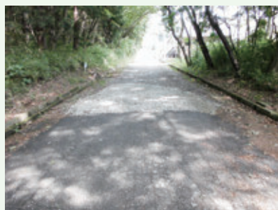
砂利入れ工事後（那珂川）
