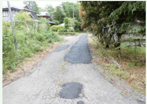
道路補修工事後（第1新那須高原）
