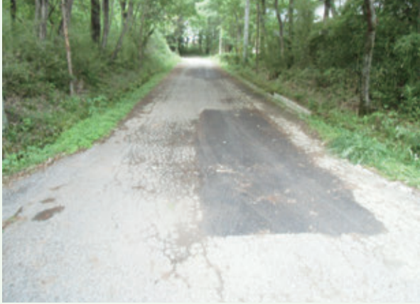
道路補修工事後（グレートハイランド）
