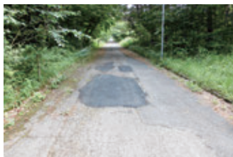
道路補修工事
