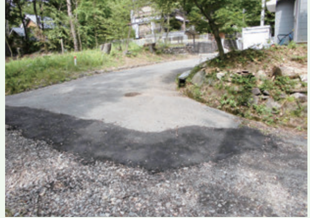
道路補修工事後（那珂川八期）
