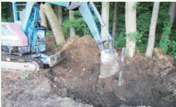
配水管の漏水修理工事（景勝苑）
