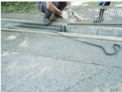
横断溝補修工事（グレートハイランド）
