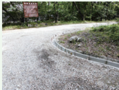
側溝補修工事後（景勝苑）
