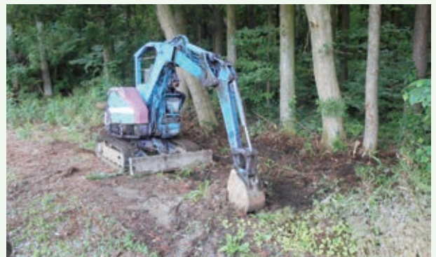
配水管の漏水修理工事（景勝苑）
