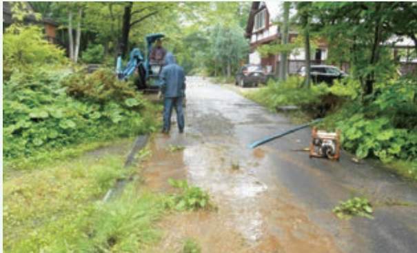
配水道路横断管の漏水修理工事（バケーションランド）
