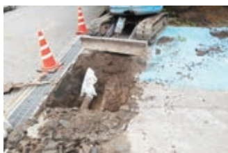
漏水修理工事
