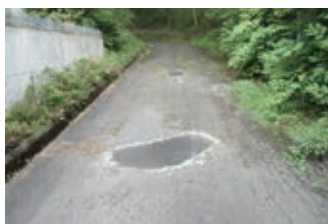
道路補修工事
