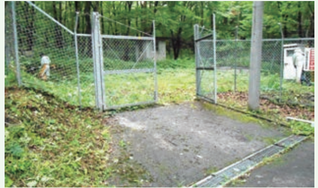
水源施設の草刈り作業（バケーションランド）
