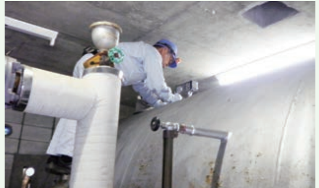
圧力タンクの圧力スイッチ修繕工事（吉野台）
