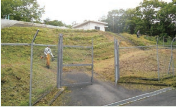
配水施設の草刈り作業（バケーションランド）
