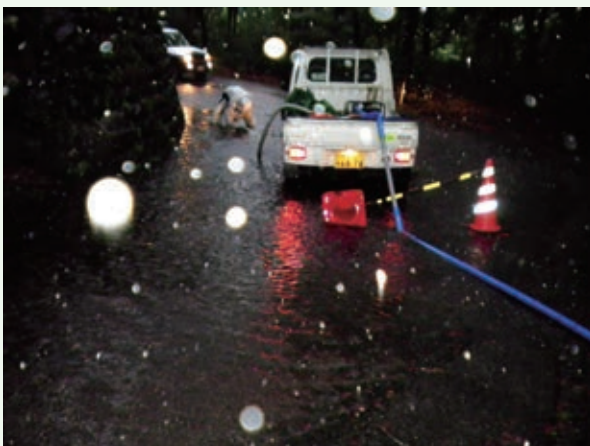
水中ポンプで雨水汲み出し作業中 (8月22日撮影)
