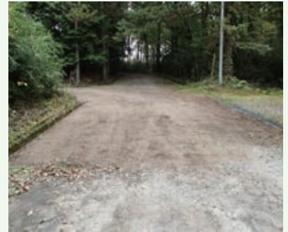
砂利入れ工事 完了 (グレートハイランド)
