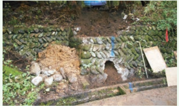
水源からの送水管漏水修理工事中（八方高原）
