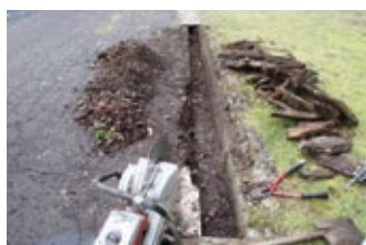
側溝補修工事
