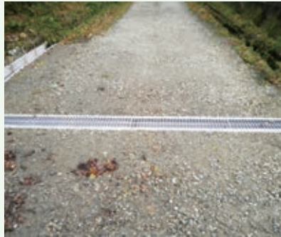
横断溝補修工事 完了 (第二緑泉苑)
