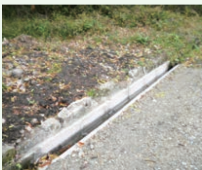
側溝補修工事 完了 (第二緑泉苑)
