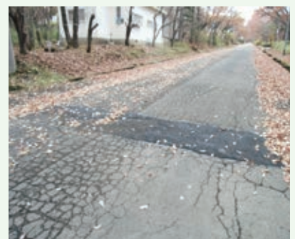
道路補修工事 完了 (バケーションランド)
