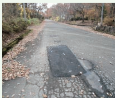
道路補修工事 完了 (バケーションランド)
