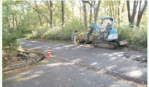
配水管分岐部分の漏水修理工事（桜台）
