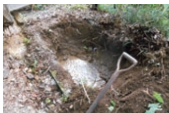
漏水修理工事
