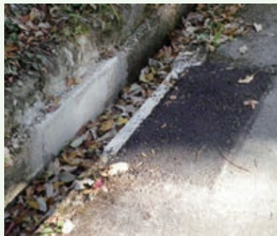
側溝補修工事 完了 (那珂川)
