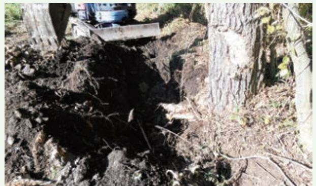
水源からの送水管漏水修理（景勝苑）
