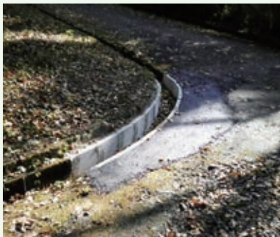
側溝補修工事 完了 (那珂川八期)
