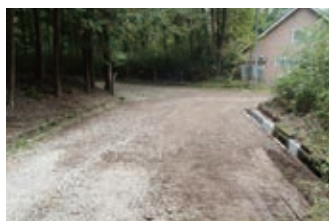
道路補修工事
