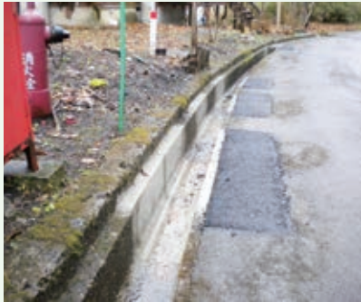
側溝補修工事 完了 (バケーションランド)
