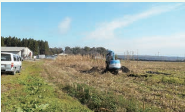
水源からの送水管漏水修理（景勝苑）
