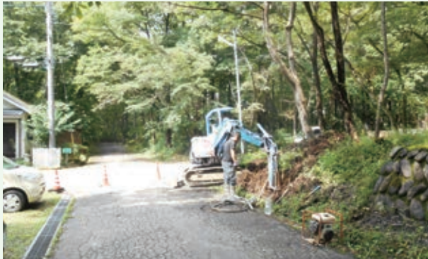
配水管分岐部分の漏水修理工事（バケーションランド）
