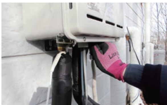
給湯器の水出し作業
