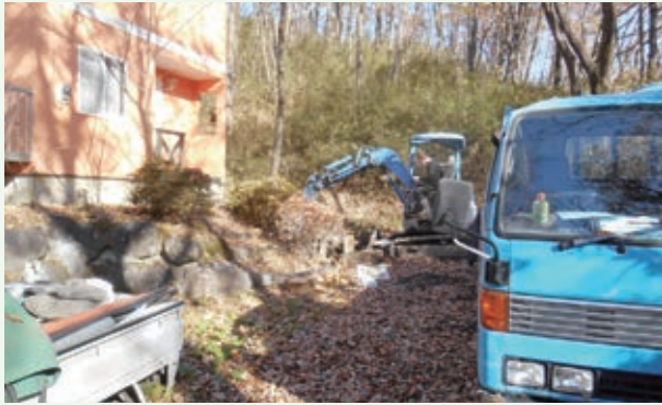
配水管分岐バルブの漏水修理工事（バケーションランド）
