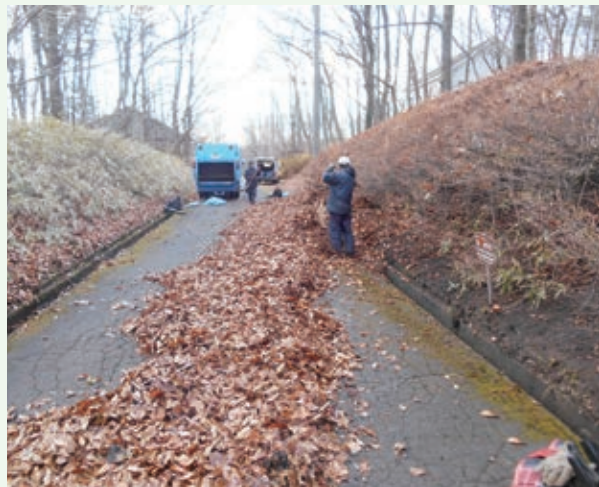
側溝清掃（バケーションランド）
