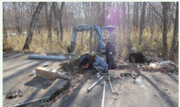
管末バルブの漏水修理工事（那珂川八期）
