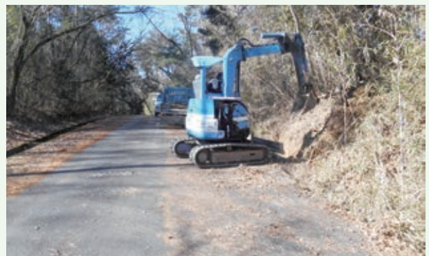
配水管の漏水修理工事（八方高原）
