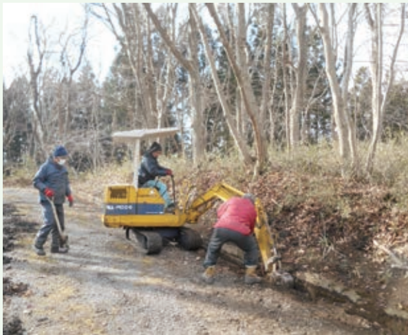
側溝清掃（那珂川）
