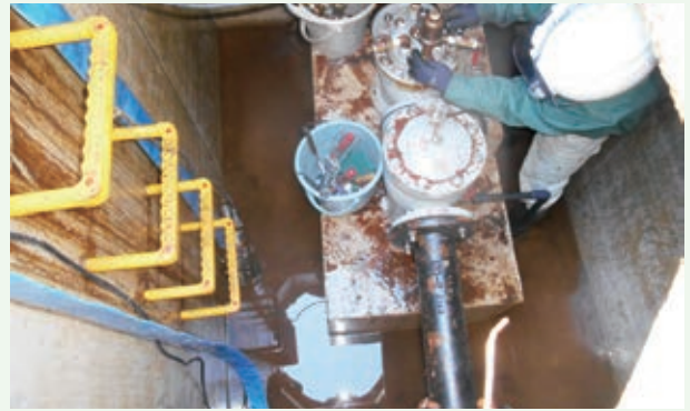
減圧弁の修繕工事（バケーションランド）
