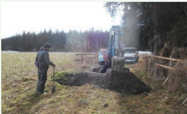
水源からの送水管漏水修理工事（景勝苑）
