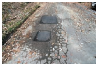
道路補修工事
