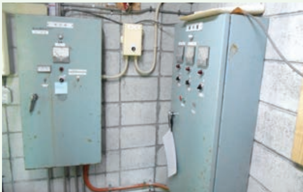
制御盤調整作業（那珂川八期）
