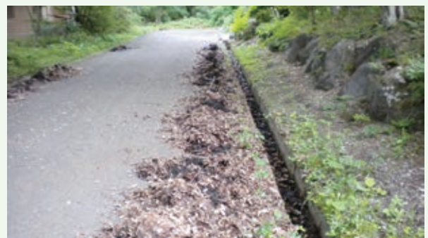
側溝清掃 (上の原高原)
