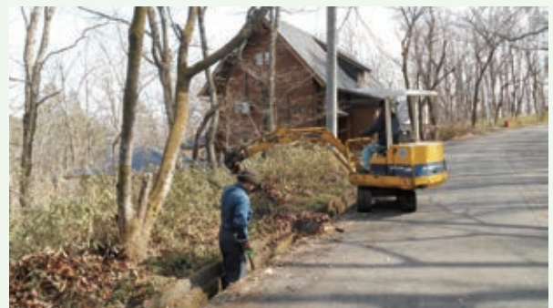
側溝清掃 (バケーションランド)
