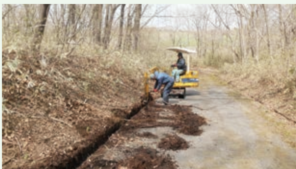
側溝清掃 (吉野台)
