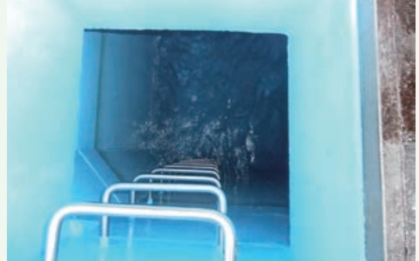
貯水槽清掃完了（バケーションランド）
