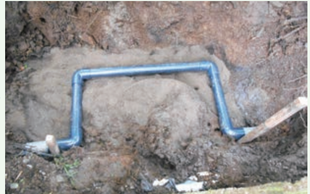
漏水修理完了（上の原高原）
