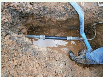
水道管破損修理工事(上の原高原)
