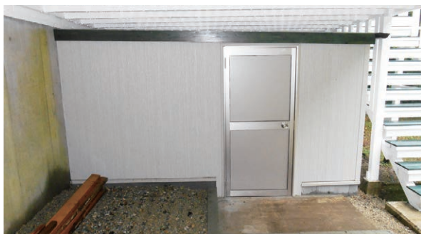
工事完了 建物外観
