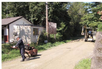
道路補修工事
