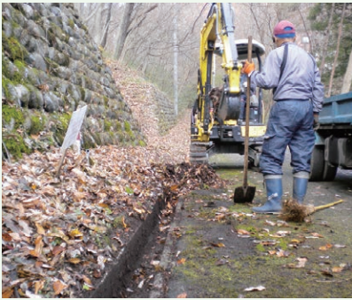
側溝清掃(バケーションランド陽地区)
