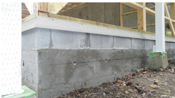
工事中 基礎部分
