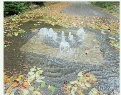
マンホールから地表への冠水(山吹台9期)
