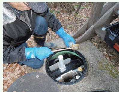
③11条検査の採水作業
