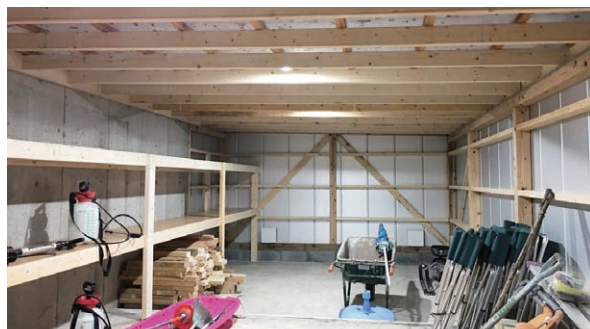
工事完了 建物内部
