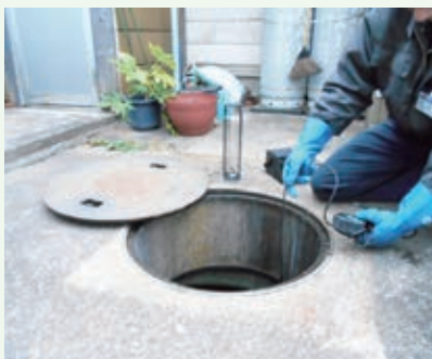
浄化槽点検作業
