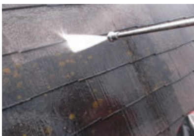
屋根の高圧洗浄作業中
