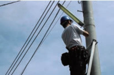
工事作業中（那珂川別荘地）
