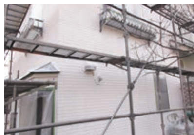
外壁塗装作業中
