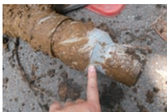
漏水修理工事
