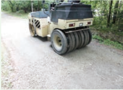
道路補修工事（景勝苑別荘地）
