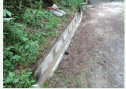
側溝補修工事（那珂川別荘地）
