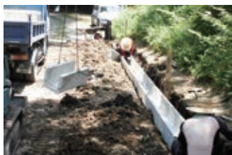
側溝補修工事
