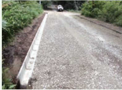
側溝補修工事 （グレートハイランド別荘地）
