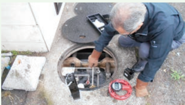
浄化槽内の点検作業
