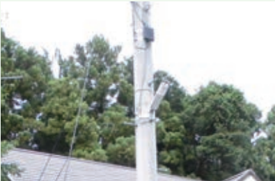
工事完了（那珂川別荘地）
