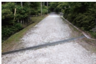
道路補修工事
