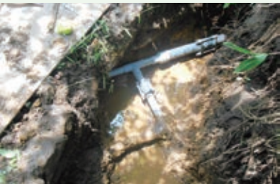
漏水修理工事 （バケーションランド別荘地）
