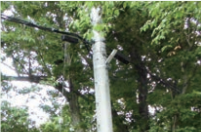
工事完了（那珂川別荘地）
