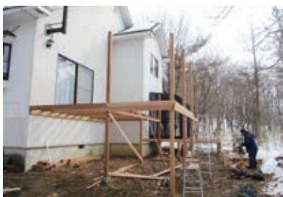
デッキ工事作業中
