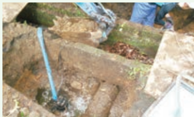
修理工事作業中
