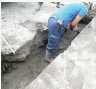
漏水修理工事（景勝苑別荘地）
