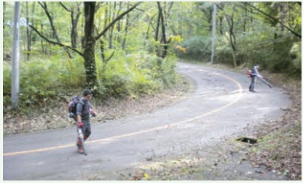
道路清掃作業中 (バケーションランド別荘地) 9月5日撮影
