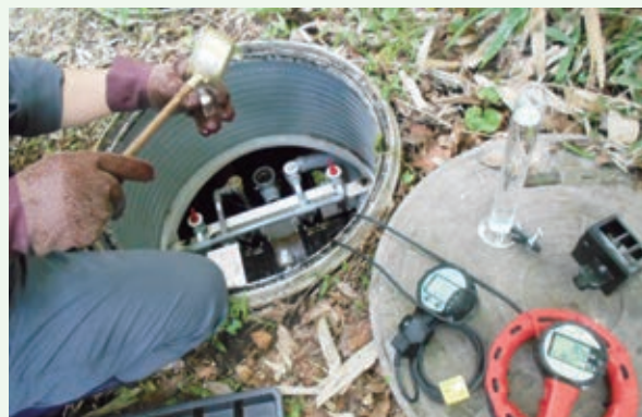
浄化槽内の点検作業
