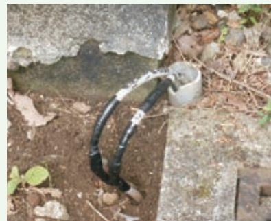
配線補修工事 (吉野台別荘地)
