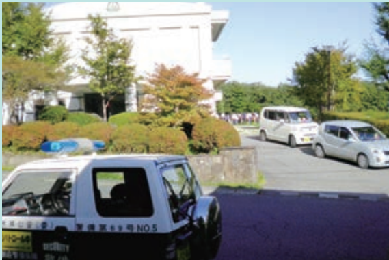
那須町立那須小学校
