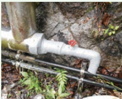
第1水源排泥バルブ補修工事 (レークサイド別荘地)
