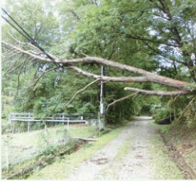
電線に掛かる倒木（第二緑泉苑別荘地） 9月5日撮影
