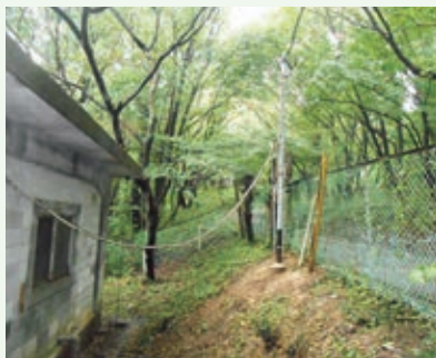
水道施設引込電柱交換工事 (長南寺別荘地)
