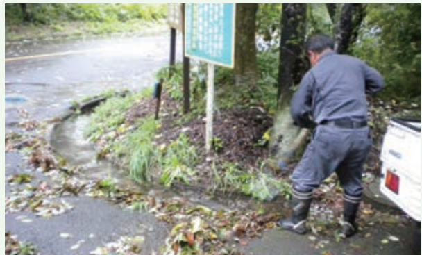
側溝清掃 (上の原高原別荘地)
