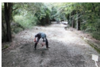
道路補修工事
