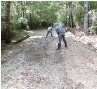
砂利道路補修工事 （グレートハイランド別荘地）
