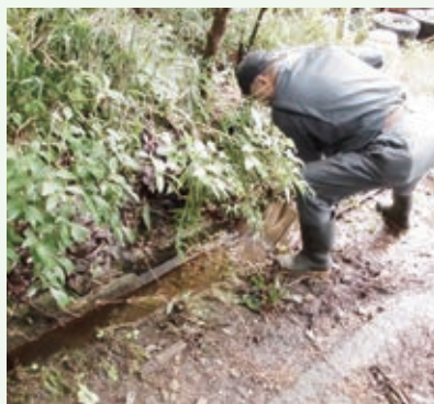
側溝清掃 （グレートハイランド別荘地）
