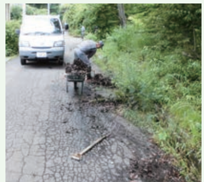
側溝清掃（山吹台9期別荘地）
