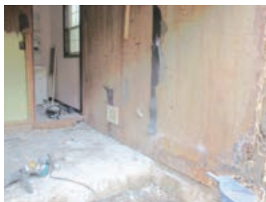
浴室解体作業中
