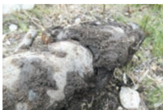
漏水修理工事
