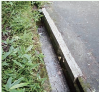
側溝補修工事（桜台）
