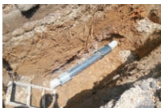
漏水修理工事
