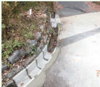
側溝補修工事（那珂川八期別荘地）
