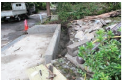
土留め工事中
