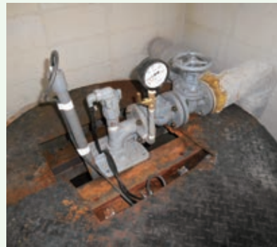
水源水中ポンプ交換工事 (桜台別荘地)
