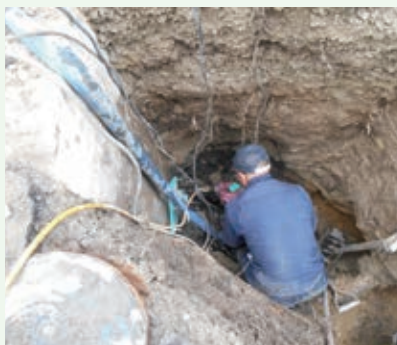
減圧弁室改修工事 (バケーションランド別荘地)
