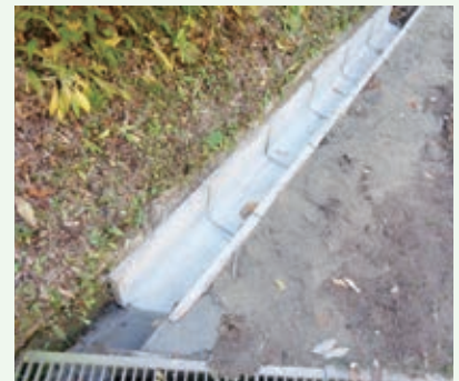
側溝補修工事 （グレートハイランド別荘地）
