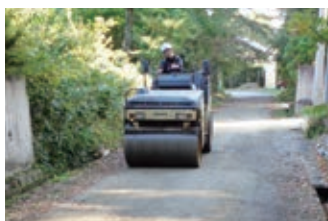
道路補修工事
