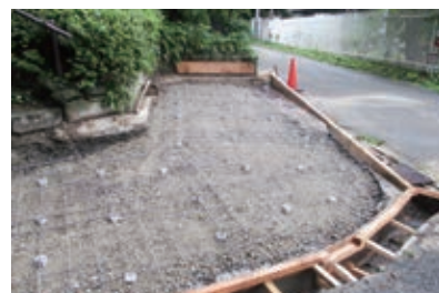
砕石転圧工事中
