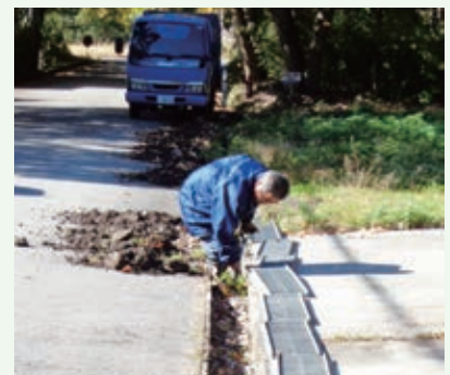
側溝清掃（第二緑泉苑別荘地）
