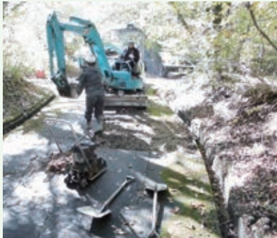
道路補修工事（桜台別荘地）
