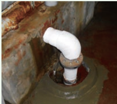
給水ポンプフード弁交換工事 (長南寺別荘地)
