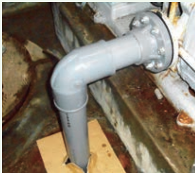
給水ポンプフード弁交換工事 (景勝苑別荘地)
