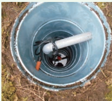
新しい浸透柵設置
