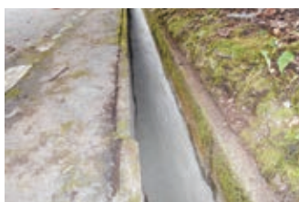
側溝補修工事
