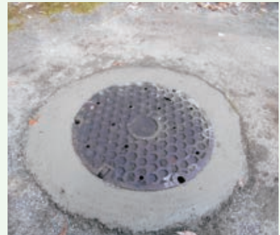
マンホール補修工事 (バケーションランド別荘地)
