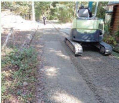
道路補修工事（景勝苑別荘地）
