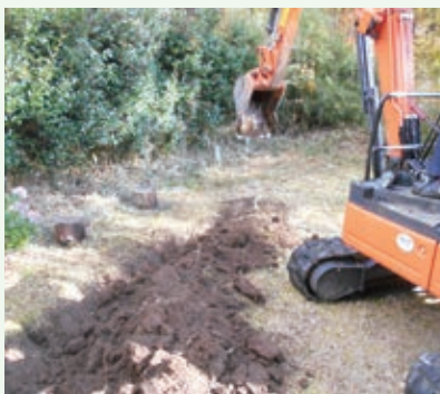
地中の掘削工事
