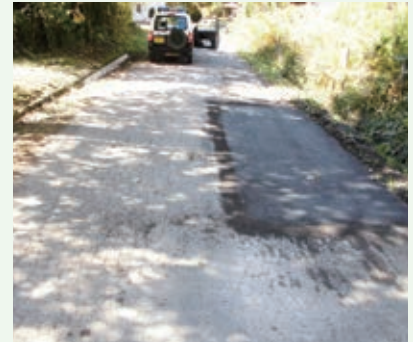
道路補修工事 （グレートハイランド別荘地）
