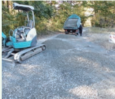
道路補修工事（第二緑泉苑別荘地）
