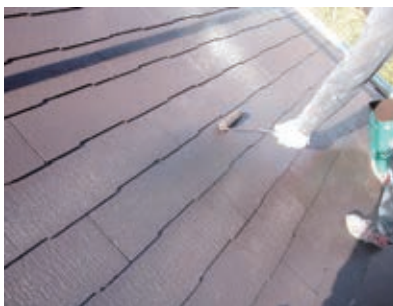
屋根 塗装作業中
