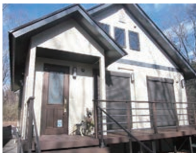
工事完了（建物外観）
