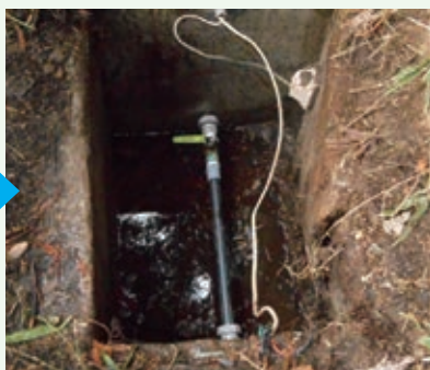
漏水修理工事 完了 (景勝苑別荘地)
