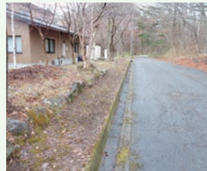
側溝清掃 (上の原高原別荘地)
