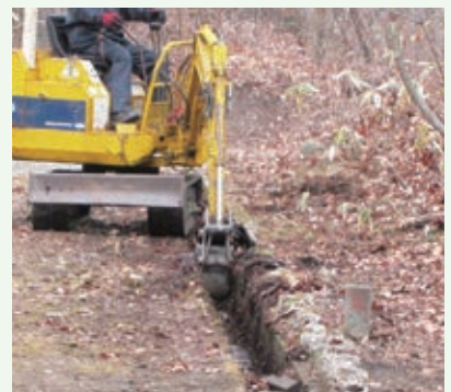
側溝清掃 (景勝苑別荘地)
