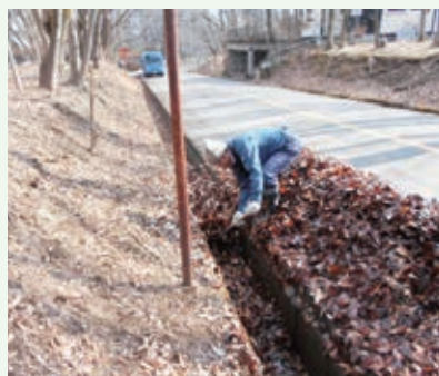
側溝清掃 (バケーションランド別荘地)
