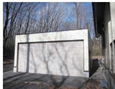
工事完了（車庫外観）
