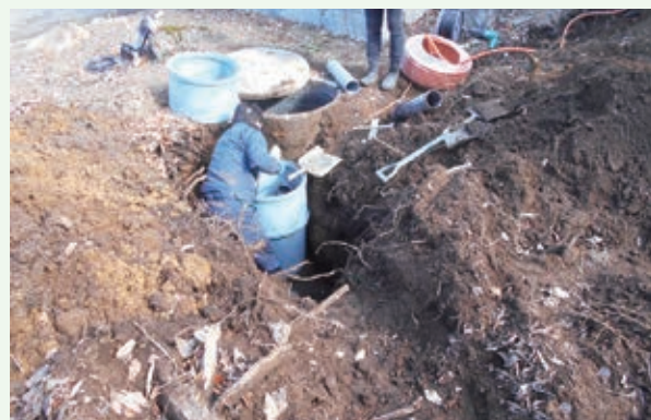
水中ポンプ及び浸透槽設置工事中
