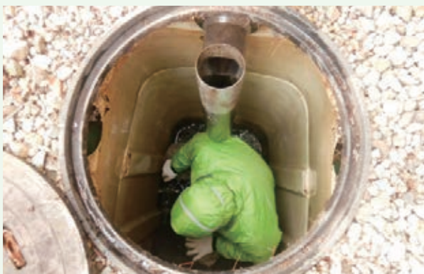
浄化槽内部 修繕工事中
