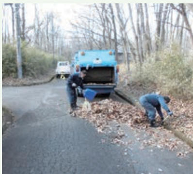
側溝清掃 (レークサイド別荘地)
