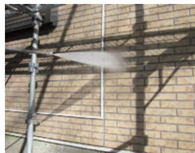
外壁 洗浄作業中
