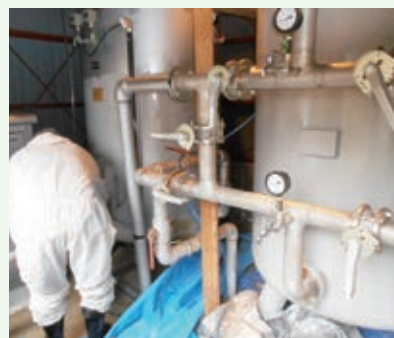
濾過槽タンクの塗装作業 (グレートハイランド別荘地)
