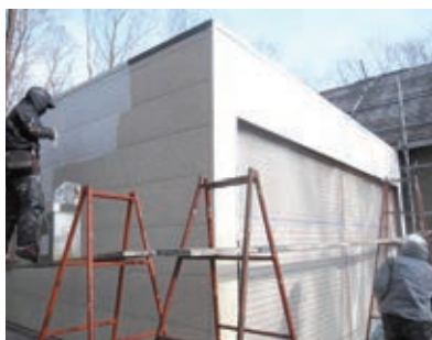
車庫 塗装作業中
