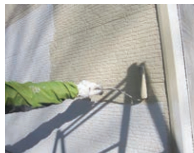
外壁 塗装作業中
