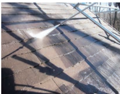
屋根 洗浄作業中
