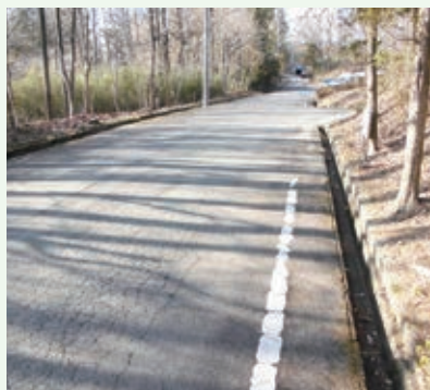
側溝清掃 (グレートハイランド別荘地)
