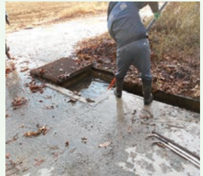
浸透枘つまり除去作業 (第二緑泉苑別荘地)
