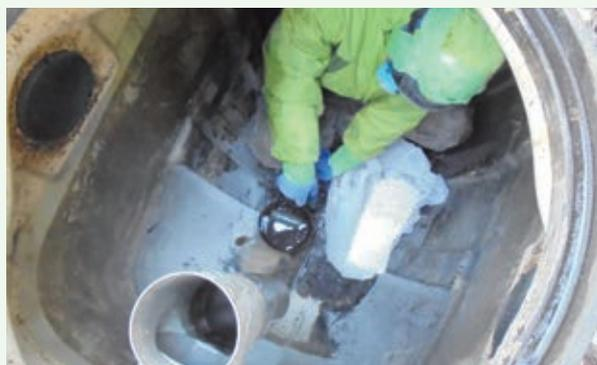
浄化槽内亀裂漏水修理工事 作業中
