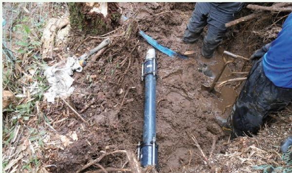
水源送水管漏水修理工事実施（八方高原別荘地）
