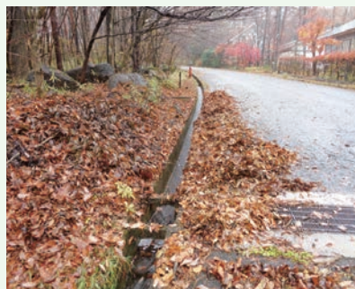
側溝清掃作業中 (上の原高原別荘地)
