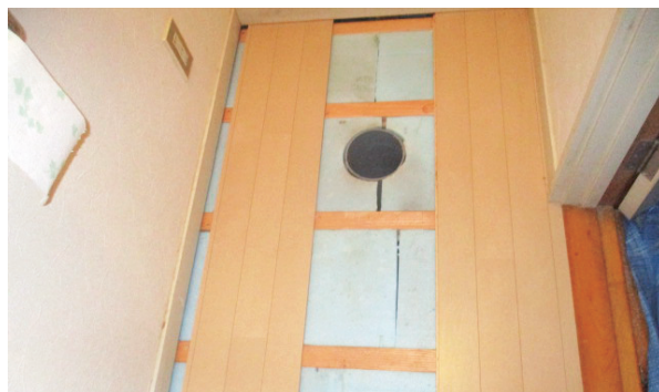
床張り作業中
