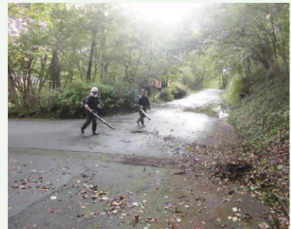
道路清掃作業中 10月13日撮影 (バケーションランド別荘地)
