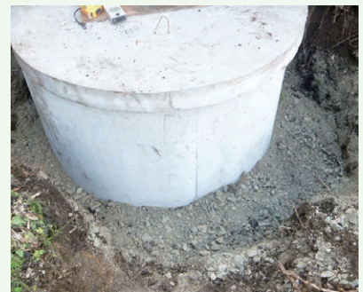
浸透枡の埋戻し作業中
