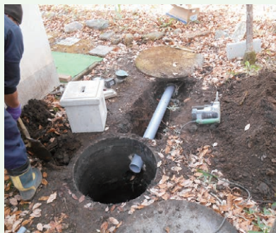
浸透枡設置工事中
