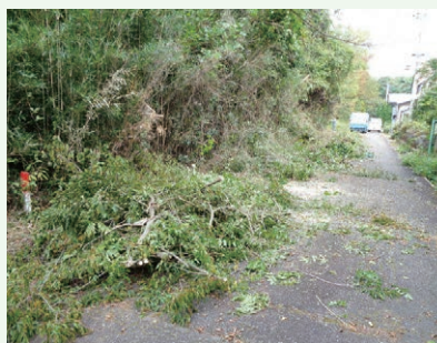
環境整備作業中 (山吹台9期別荘地)
