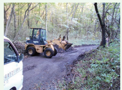
橋下清掃作業中 (吉野台別荘地)
