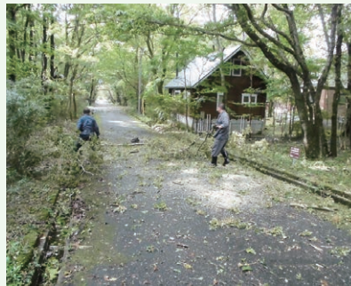
倒木処理作業中 10月13日撮影 (バケーションランド別荘地)
