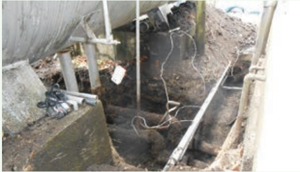
施設内配管の敷設替工事前（那珂川八期別荘地）
