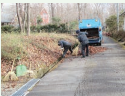
側溝清掃作業中 （山吹台9期別荘地）
