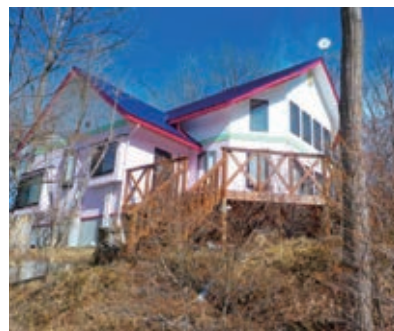
工事完了(外観)
