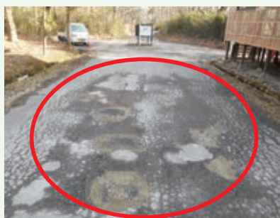
道路補修工事 完了 （グレートハイランド別荘地）
