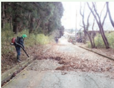
側溝清掃作業中（那珂川別荘地）
