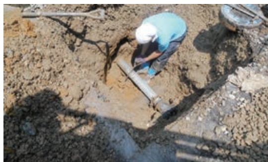
給水管漏水修理・維持管理
