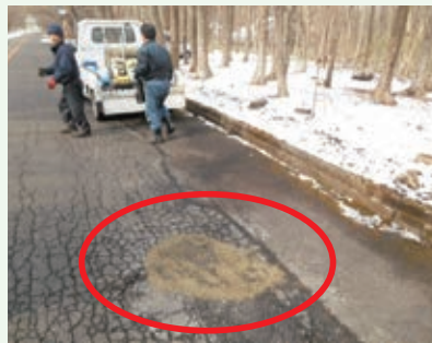
道路補修工事 完了 (バケーションランド別荘地)
