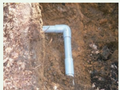
漏水修理工事（長南寺別荘地）
