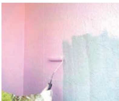
外壁塗装工事中
