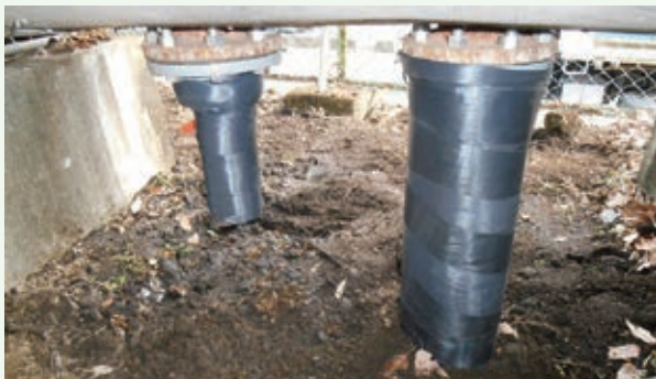
施設内配管の敷設替工事完了（那珂川八期別荘地）
