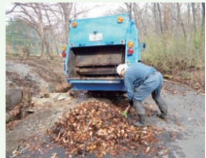
側溝清掃作業中 (上の原高原別荘地)
