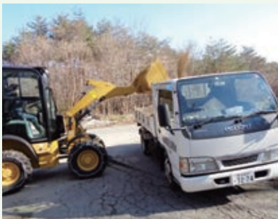
道路の土砂の撤去作業 (上の原高原別荘地)
