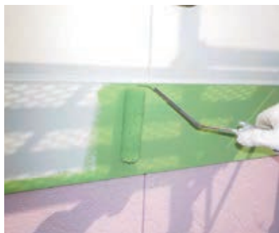
横帯塗装工事中
