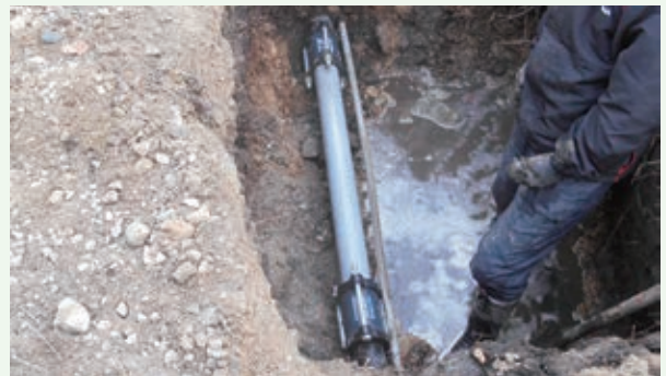
配水施設間送水管漏水修理工事（景勝苑別荘地）
