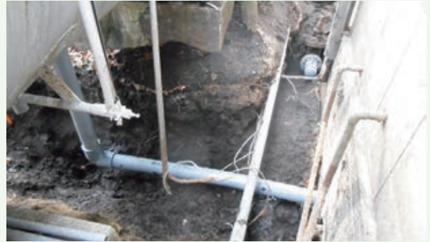
施設内配管の敷設替工事作業中（那珂川八期別荘地）
