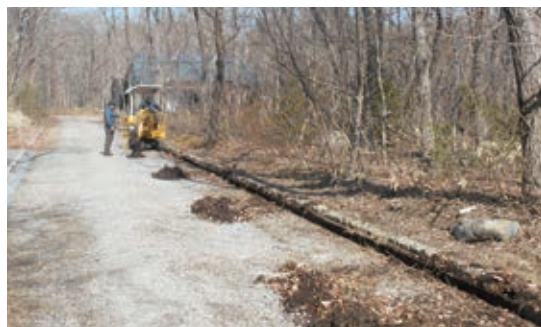
側溝清掃・補修
