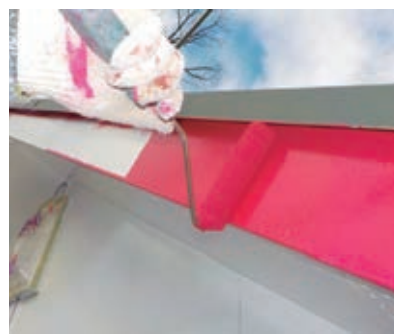
破風塗装工事中
