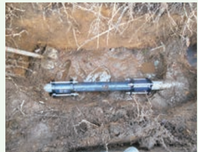
漏水修理工事 (バケーションランド別荘地)
