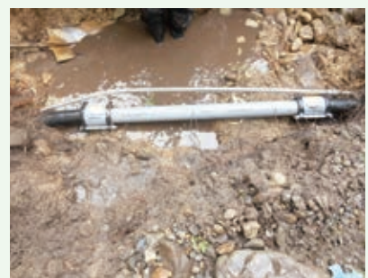
漏水修理工事(景勝苑別荘地)
