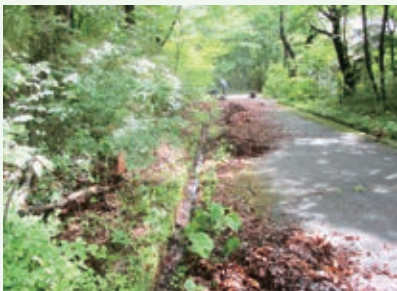
側溝清掃 (上の原高原別荘地)
