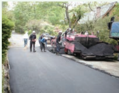
道路修繕工事 作業中 (グレートハイランド別荘地)
