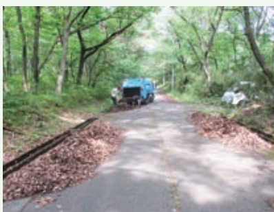
側溝清掃(桜台別荘地)
