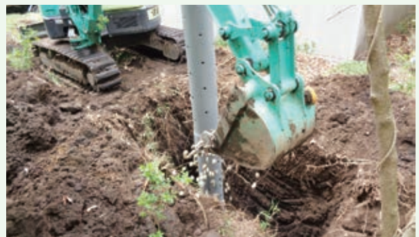
既存の浸透槽より接続する浸透槽設置工事
