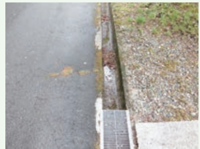
側溝補修工事 完了 (山吹台9期別荘地)
