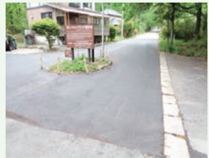
道路修繕工事 完了 (グレートハイランド別荘地)
