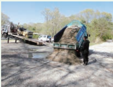
砂利敷き工事 作業中 (第二緑泉苑別荘地)
