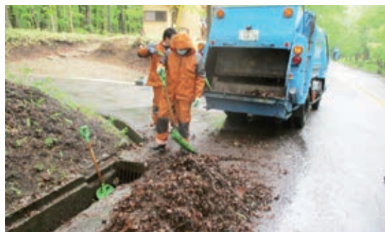
側溝清掃・補修
