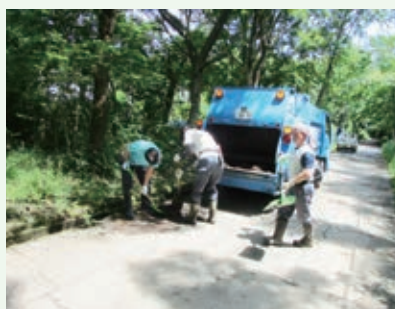
側溝清掃(那珂川別荘地)
