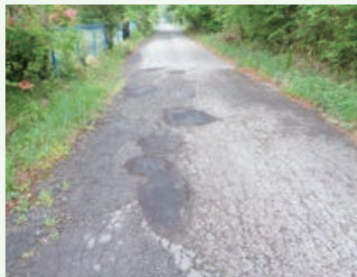
補修工事 完了 (第1新那須高原別荘地)
