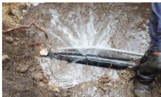
給水管漏水修理・維持管理
