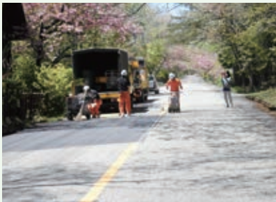
道路修繕工事 作業中 (バケーションランド別荘地)
