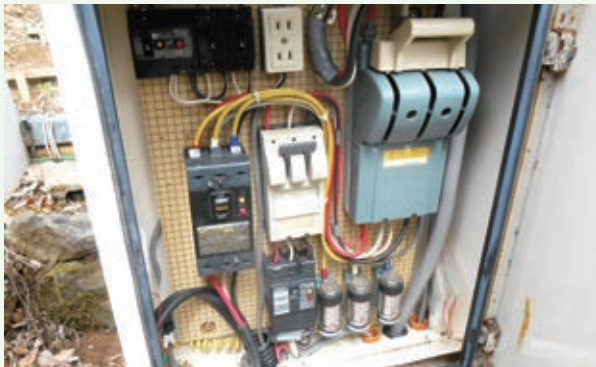
計器類調査実施（グレートハイランド別荘地）
